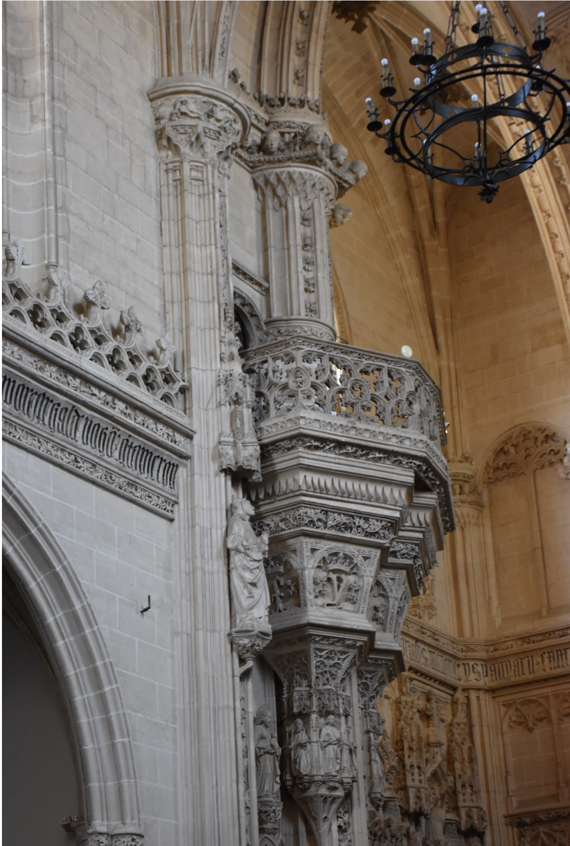
Figure 50, détail d'un balcon du chœur de l'église du monastère San Juan de los Reyes, Tolède, 2026, photo de Duvivier Camille.
