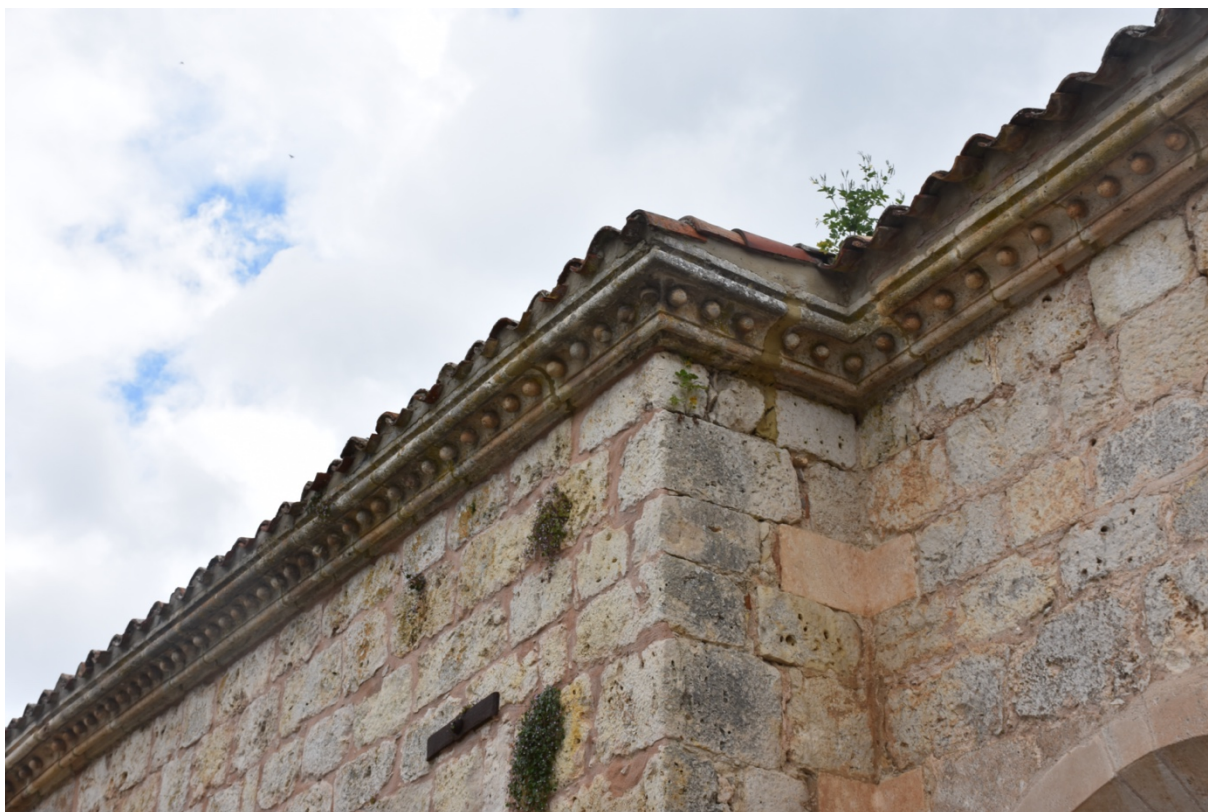
Figure 34, détail du monastère chartreux de Miraflores, Burgos, 2026, photo de Duvivier Camille.
