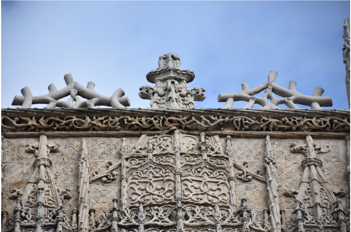
Figure 15, détail de la façade de San Gregorio, Valladolid, 2026, photo de Duvivier Camille.
