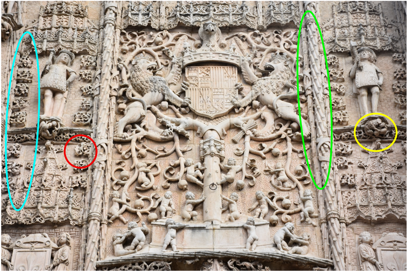
Figure 1, détail de la façade de San Gregorio, Valladolid, 2026, photo de Duvivier Camille
