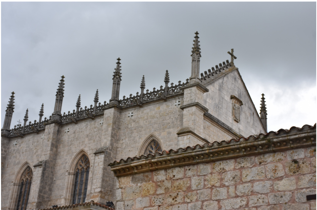
Figure 11, détail du monastère chartreux de Miraflores, Burgos, 2026, photo de Duvivier Camille.
