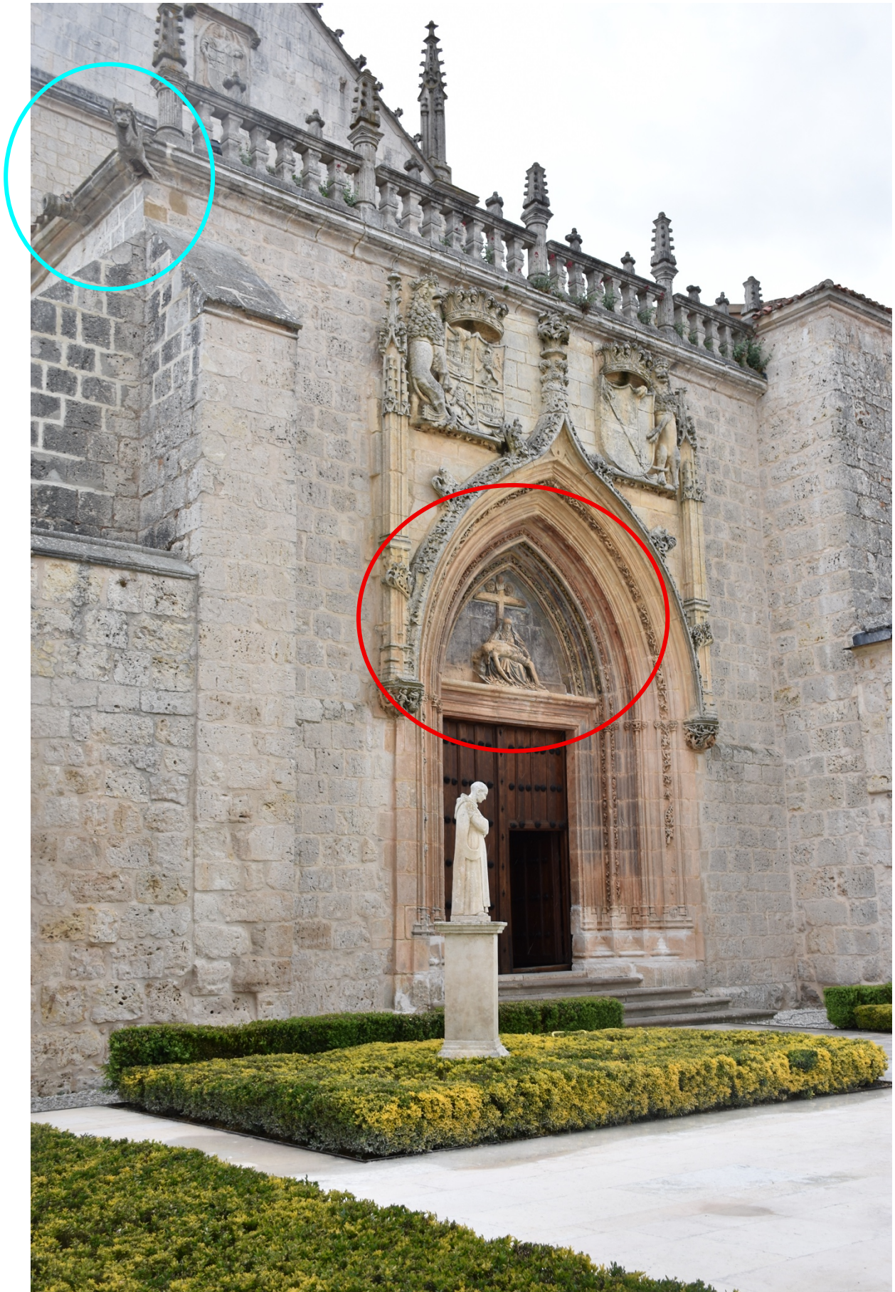
Figure 25, détail du monastère chartreux de Miraflores, Burgos, 2026, photo de Duvivier Camille.
