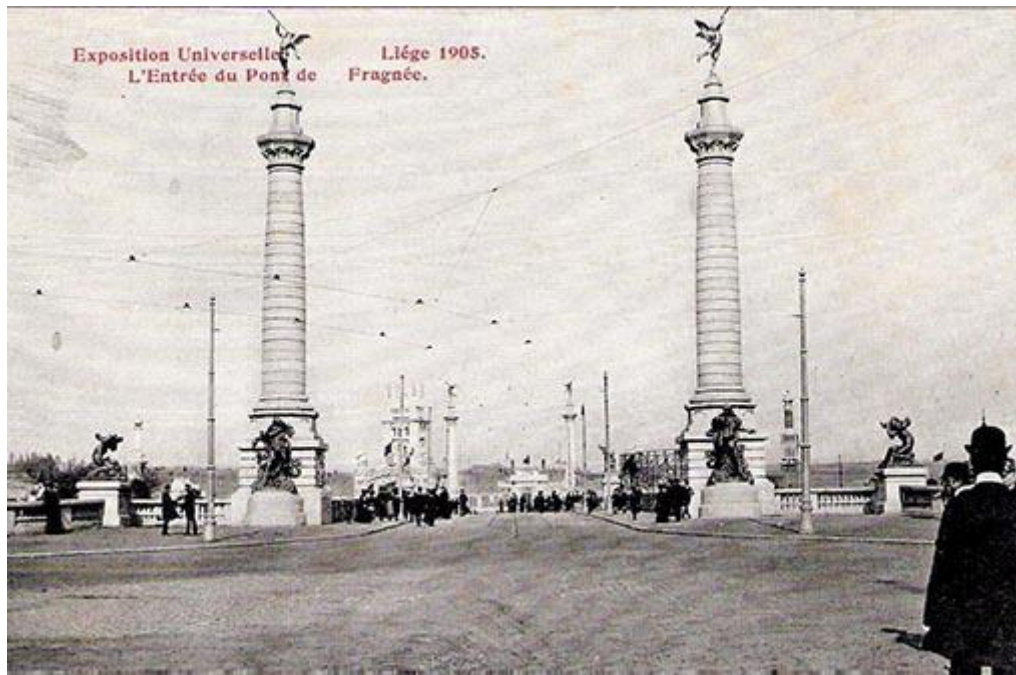
Fig. 10 L'entrée du Pont de Fragnée à l'Exposition Universelle de Liège 1905.
