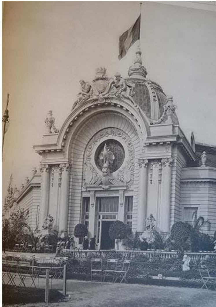
Fig. 41 Entrée du Pavillon de la Ville de Paris à l'Exposition Universelle de Gand 1913, Photo.
