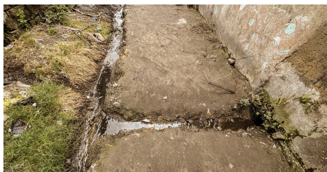
Fig. 33 – Récupération des eaux de pluies, AUTEURE 2026
