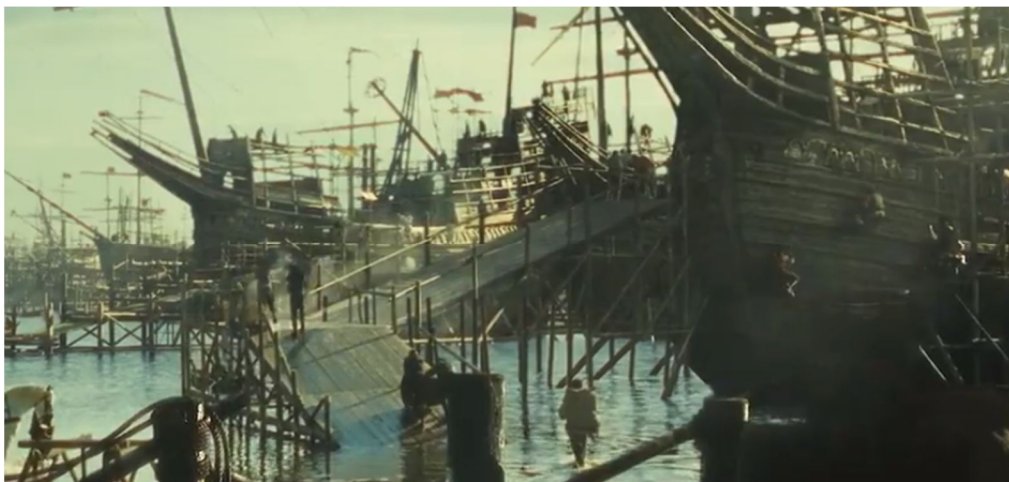
Fig. 58. Construction de l'Armada . (KAPUR S., Elizabeth : the Golden Age , 2007, 00 41' 23'').
