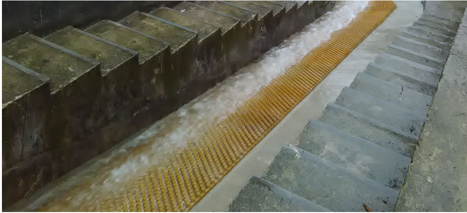
FIGURE 4.8 – Exemple d'un substrat de type plot utilisé pour la passe de Monsin (Belgique).
