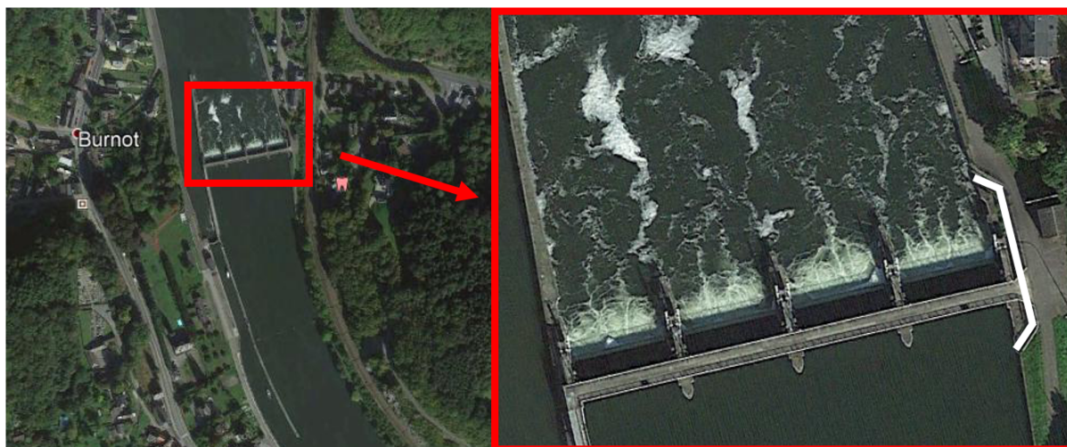
FIGURE 1.3 – Situation du barrage de Rivière (en rouge) et de sa passe à poissons (en blanc).
