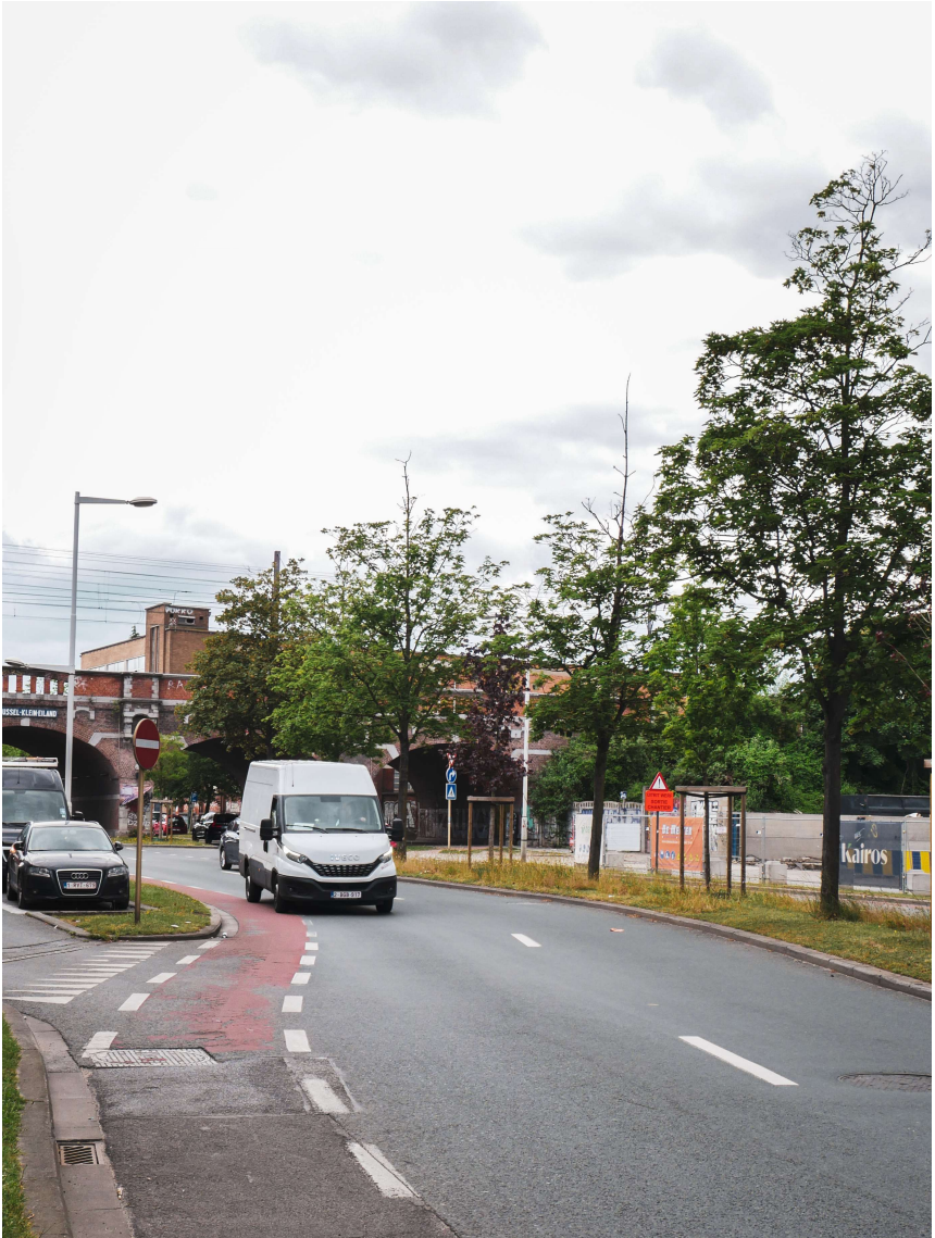
Fig.36 Piste cyclable dangereuse, rue des deux gares
