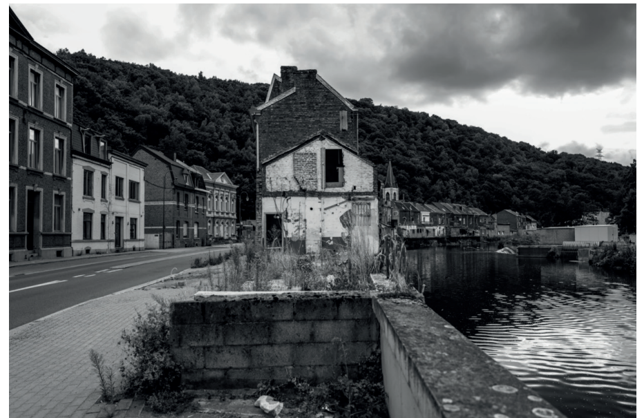
Figure 12 : Photographie des dégâts des inondation sur une maison bordant la Vesdre (Deprez, 2021).
