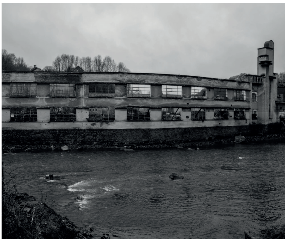
Figure 26: Ancienne usine textile de Verviers aujourd'hui détruite (Deprez, 2021).
