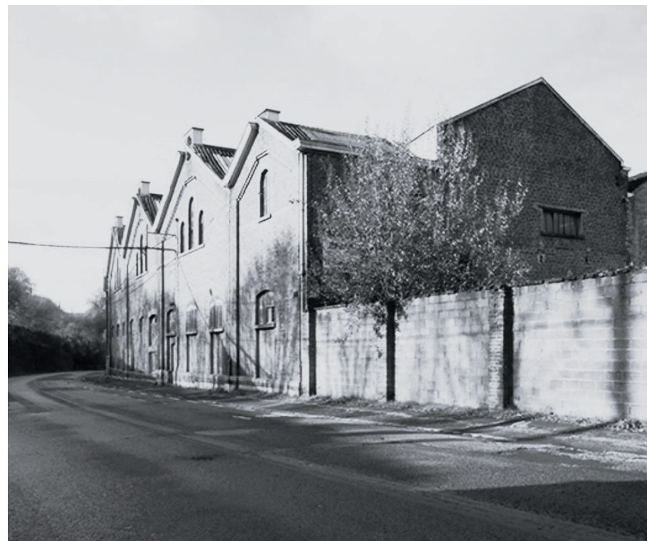
Figure 33 : Vue sur le Solvent Belge (à droite) depuis la rue du Limbourg (Joris, 2018).
