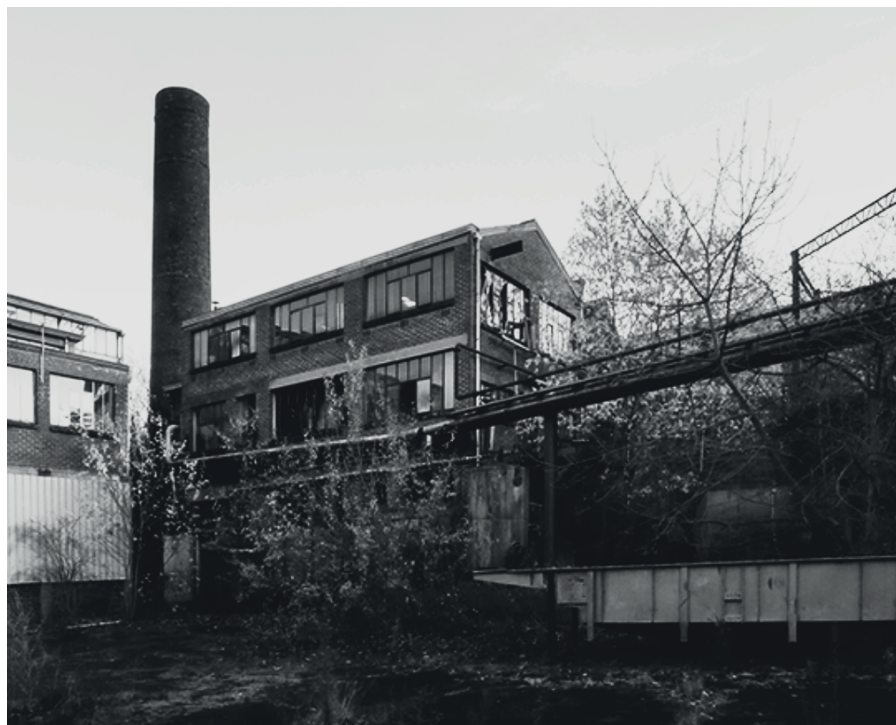
Figure 34: Ancien atelier de fabrication de la Solventine (Joris, 2018).
