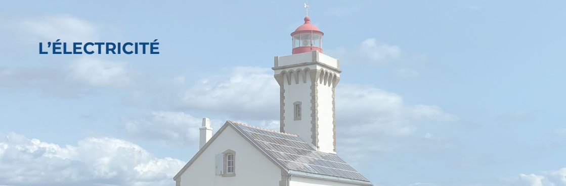
Fig212. Photo du phare des Poulains, équipé de panneaux photovoltaïques
