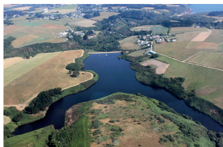
Fig210. Retenue d'eau de Borfloc'h, ©Eau du Morbihan
