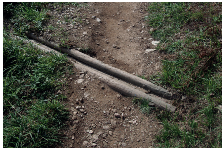
Fig43. Éléments permettant le passe des eaux pluviales en limitant ses dégradations sur le sentier
