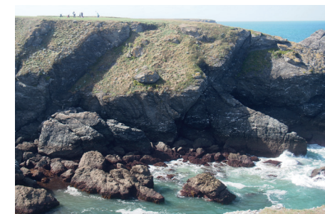
Fig93. La roche se détache, les falaises prennent de la hauteur
