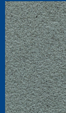
Enduit à la chaux
