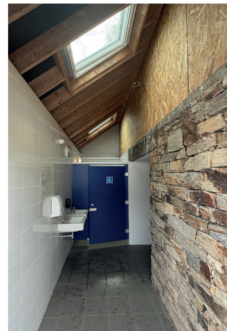
2 -Entrée Toilettes avec lavabo
