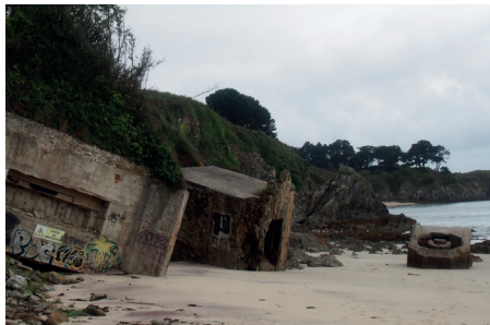
Fig225. Chutes de Blockhaus sur la plage dû aux éboulements et à l'érosion des roches
