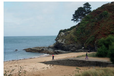
Fig140. Rampe de mise à l'eau de Port Blanc
