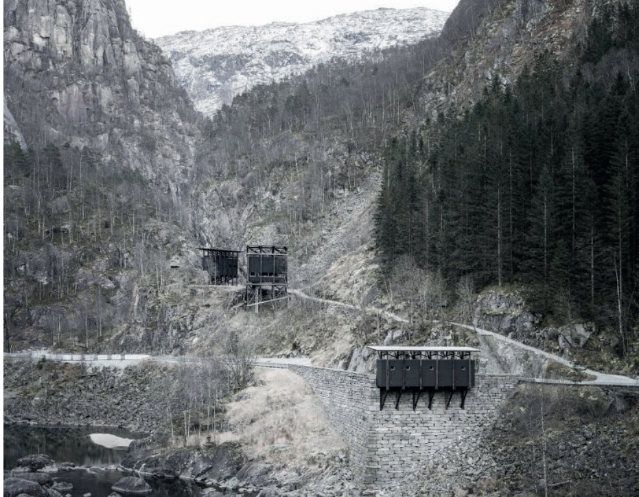
Fig90. Photo du «Musée de la Mine», par Zumthor, © Aldo Amoretti, sur Divisare, https://divisare.com/projects/341031-peter-zumthor-aldo-amoretti-zinc-mine-museum-at-allmannajuvet
