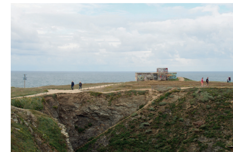
Fig114. La station radar visitée, l'escalier vers le crénneau de défense inférieur se dissimule dans la roche
