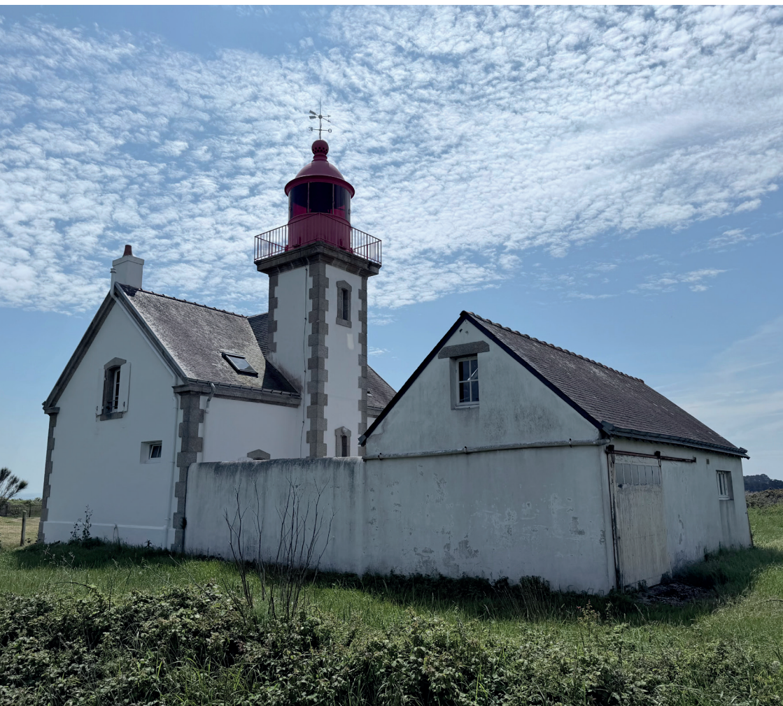
Fig253. Photos de l'état existant du Phare de Kerdonis (obsoleète depuis l'automatisation de la lanterne, la maison du gardien n'est plus habitée, en rade, depuis près de 50 ans)
