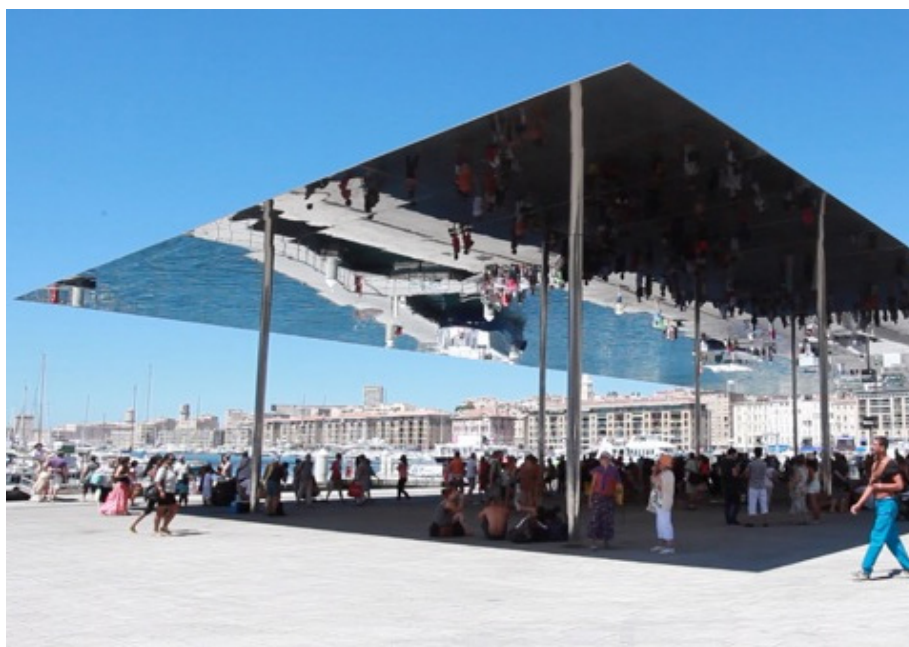
Fig. 43 : Ombrière du Vieux Port de Marseille, Noman Foster, Marseille, 2013
