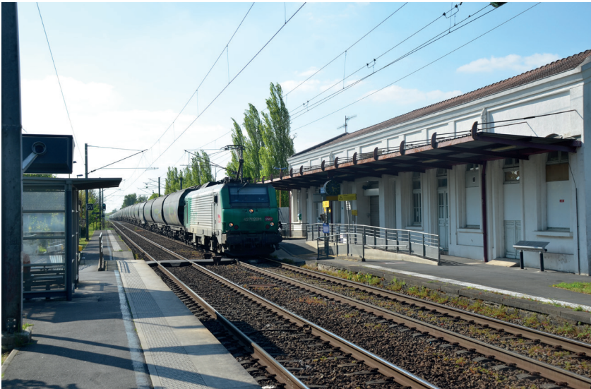
Fig 80 : Quais de la gare
