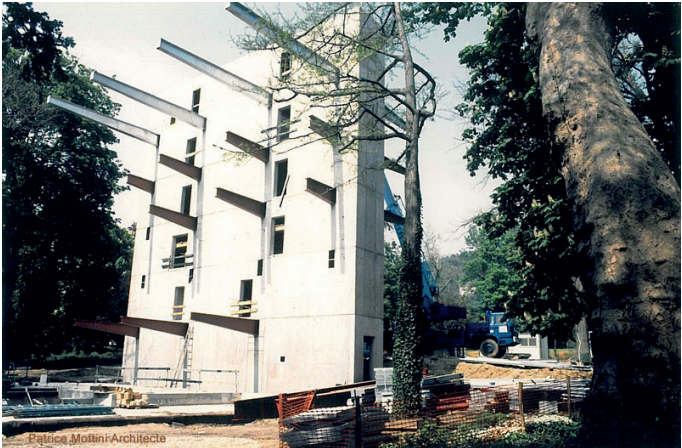
Fig 61 : Chantier de Construction des Nouveaux Ateliers du Parc, à Rouen Darnétal. 1995. © Patrice Mottini architecte
