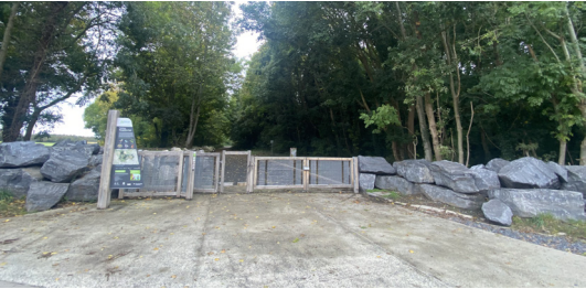
1 Entrée rue de Boussac
