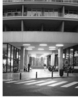
GALERIE DU PARLEMENT 1880 Transformed
