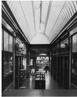
PASSAGE BORTIER (1847-48) Transformed
