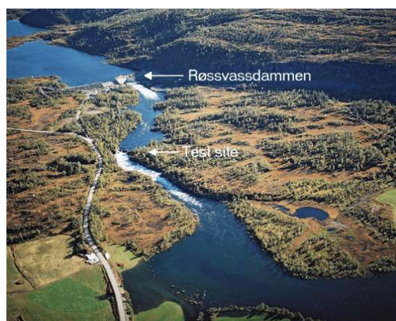
FIGURE 2.9 – Site des essais à grande échelle pour le projet Impact[12]
