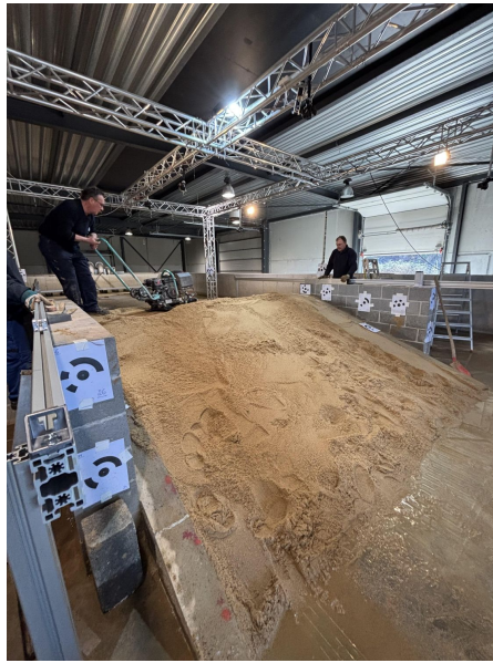
FIGURE 3.11 – Compaction à l'aide de la dameuse
