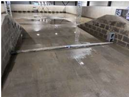
(a) Drain posé en 2024[7]
