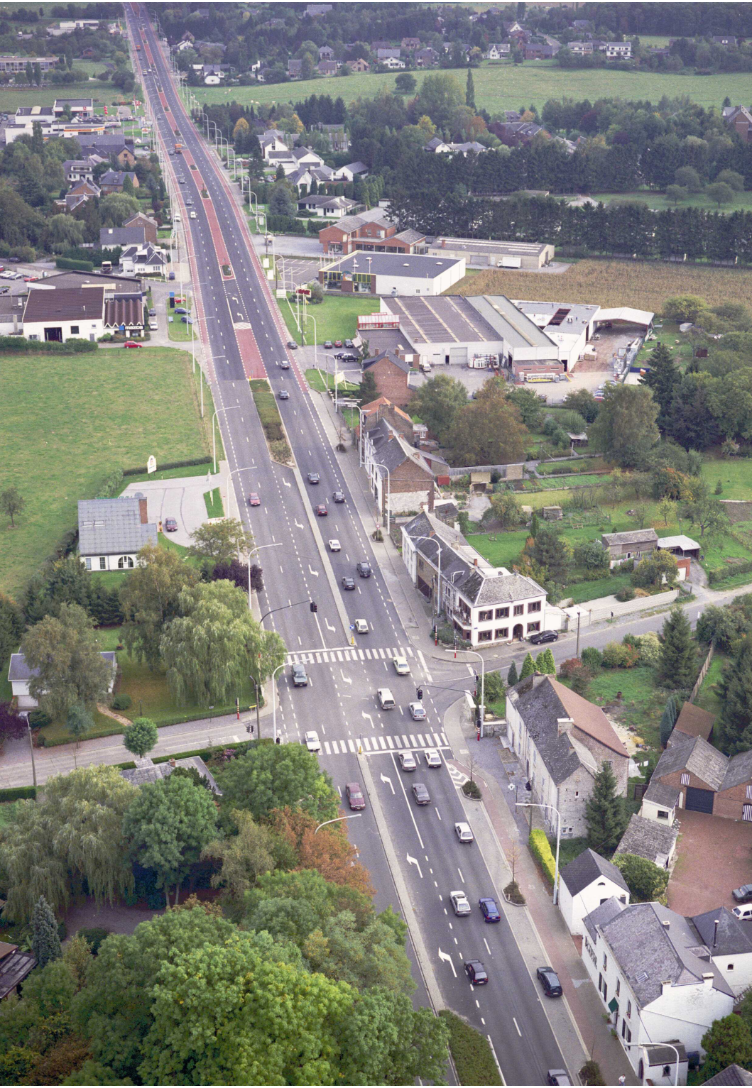
Photos de la Chaussée de Marche , Archives Wallonie, 1995
