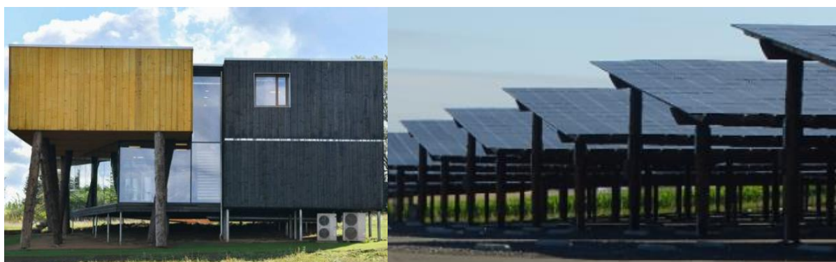
Figure 5 Up Straw, bureaux du Cluster Eco-construction wallon, Pairi Daiza et son parking photovoltaïque en grumes, Belgique.
