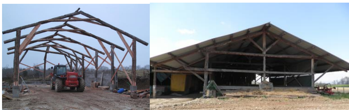
Figure 6 : Charpente en bois rond et la ferme du Mont Charvet, France
