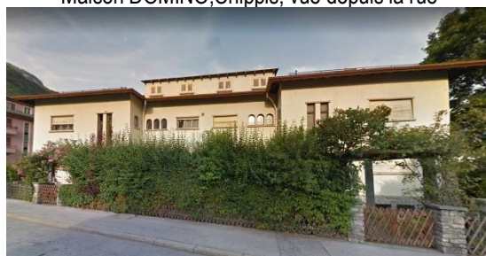
Maison DOMINO, Chippis, vue depuis la rue
