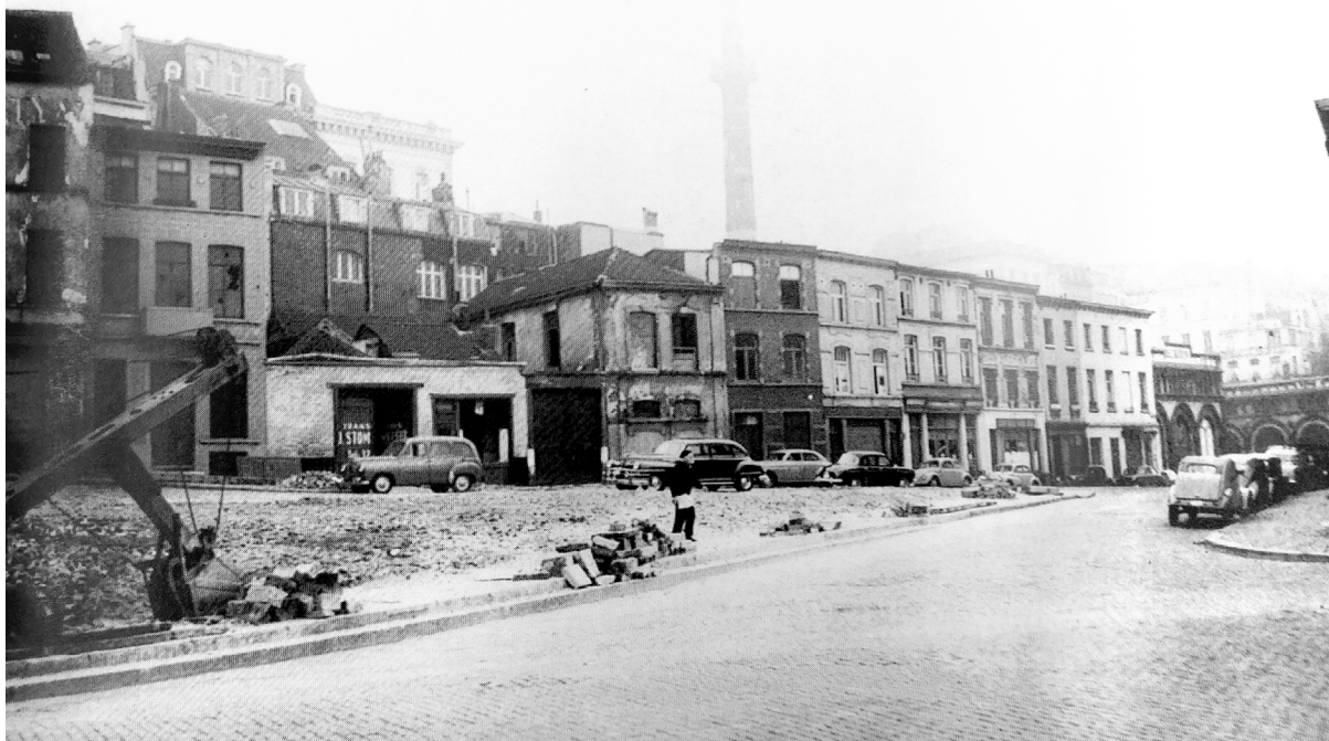
Les Bas Fonds, avant démolition - Fig. 71
