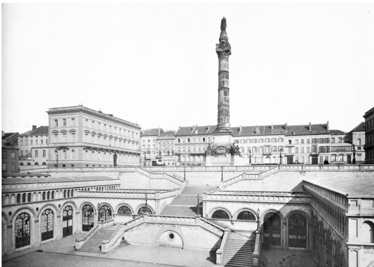
Escalier reliant la Place du Congrès au marché du Parc et au bas de la ville, avant démolition - Fig. 70
