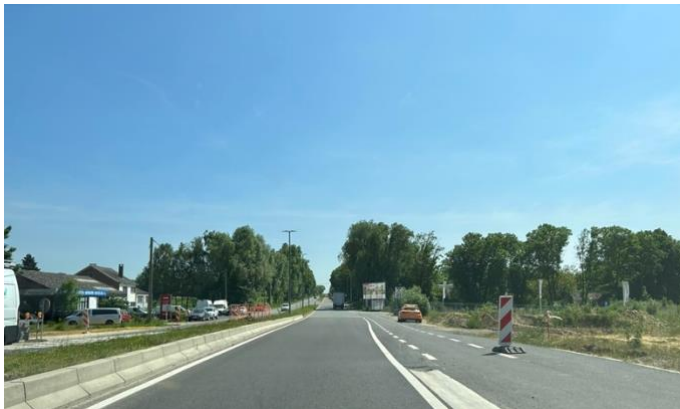
Illustration 39 : Photographie de la N4 en direction de la rue de la flèche (Photographie personnelle).
