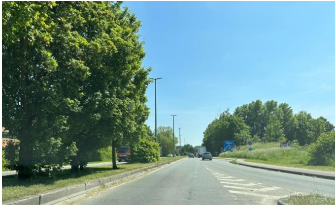
Illustration 36 : Photographie après le giratoire, en direction du boulevard de la Wallonie et le boulevard du Brabant wallon (Photographie personnelle).
