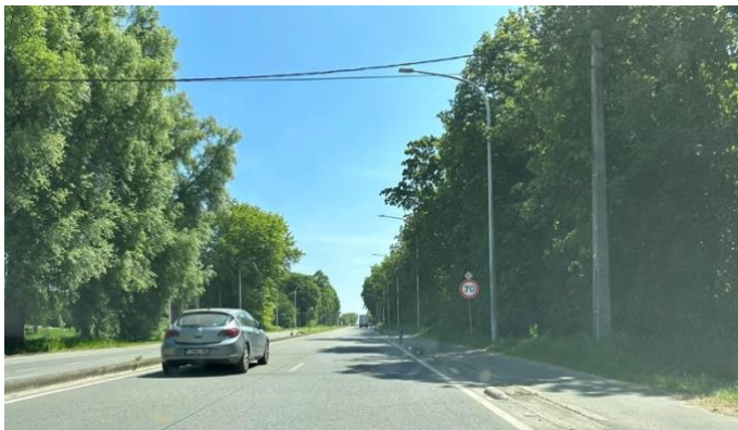
Illustration 40 : Photographie de la N4 en direction de la rue de la flèche (Photographie personnelle).
