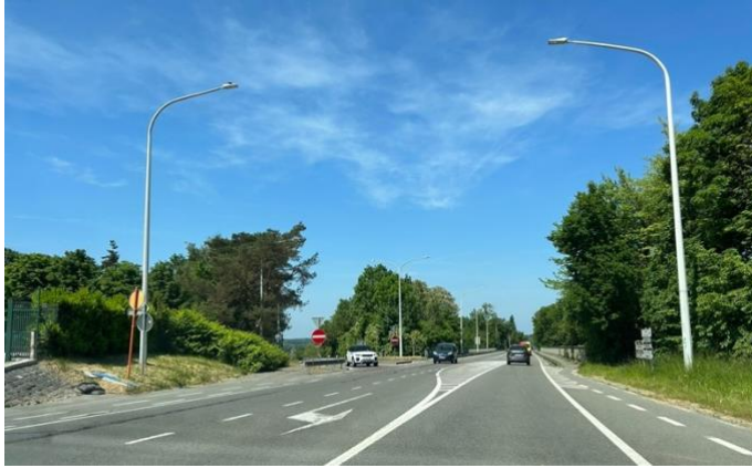
Illustration 32 : Photographie au croisement de la E411 et de la N4, près de la caserne des pompiers de Wavre (Photographie personnelle).
