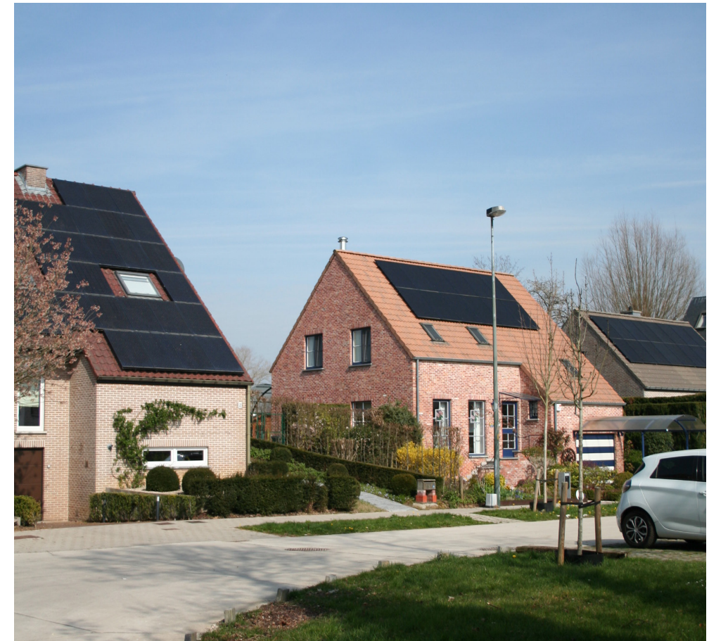
Villas 4 façades à Sterrebeek. Figure 6
