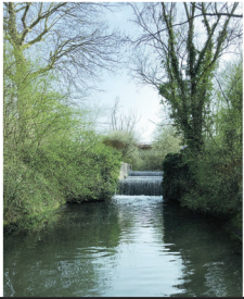
Ecluse Coeur de Deûle, garant d'un itinéraire de plaisance continue.
