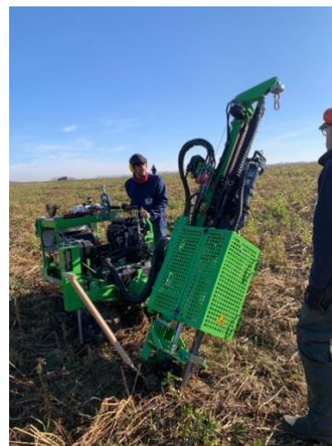
Figure 10 : Prélèvement de carottes de sol à l'aide d'une carotteuse GTR-790 inclinée à 30°, 4 mars 2025
