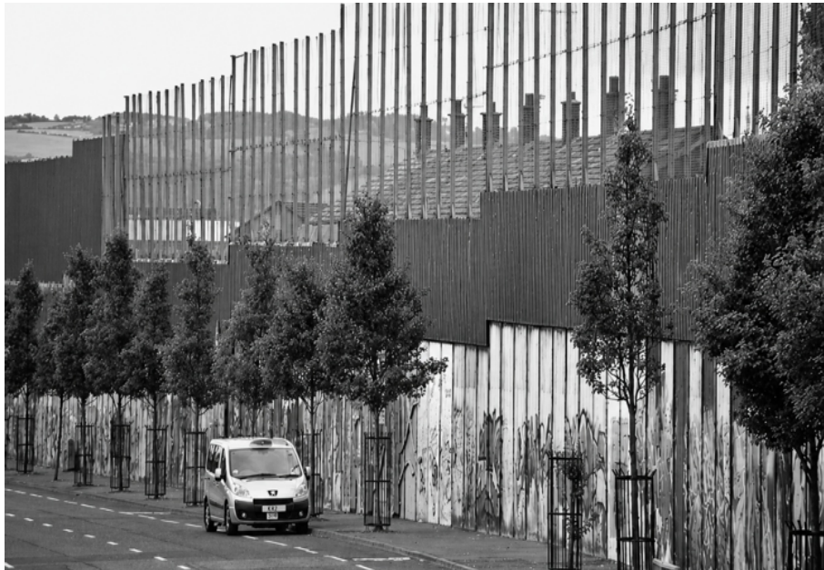
Fig 3. Le mur de paix longeant les routes Falls et Shankill à Belfast, barrière érigée en 1969 pour séparer quartiers catholiques et protestants, devenue structure permanente inscrivant durablement la fragmentation communautaire dans le tissu urbain. (Mike McBride, 2023)
