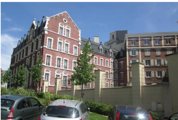
Fig. 96. O. Masson et D. Vanneste, Façade de l'îlot , s.d., photo, Inventaire des formes de logements.
