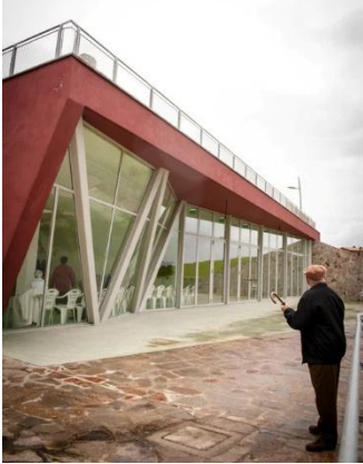
Fig. 115. LGSMA IaN+, Façade Ouest , s.d., photo, LGSMA IaN+.
