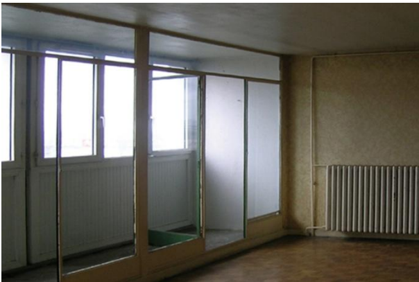
Fig. 22. Druot, Lacaton & Vassal, Intérieur existant , s.d., photo, Lacaton & Vassal.
