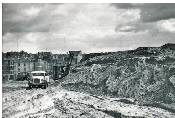
Fig. 143. Le chantier de l'avenue de la Sauvagine avec en arrière-plan la place Keym, photo, 1960, AUW-B.
