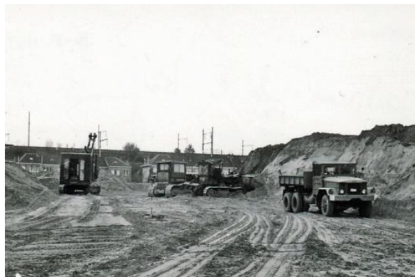
Fig. 141. Le chantier de l'avenue de la Sauvagine avec en arrière-plan les caténaires du chemin de fer, 1962, photo, Collection Jean-Pierre Huts.
