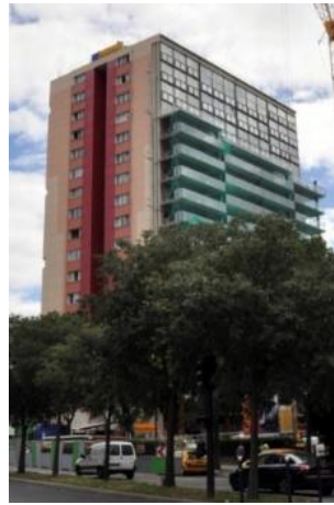
Fig. 20. Druot, Lacaton & Vassal, Transformation de la tour , s.d., photo, Lacaton & Vassal.
