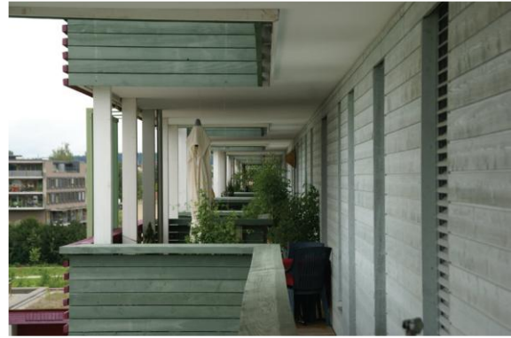
Fig. 99. O. Masson et D. Vanneste, Balcons rajoutés à la façade , s.d., photo, Inventaire des formes de logements.
