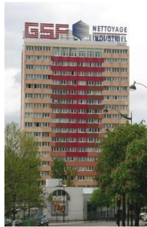
Fig. 19. Druot, Lacaton & Vassal, Existant / rafraîchissement , 1990, photo, Lacaton & Vassal.
