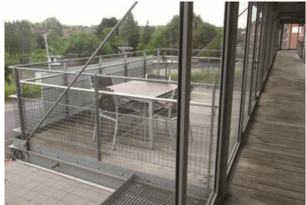
Fig. 85. O. M. et D. V, Terrasse et coursive de la résidence-services , s.d., photo, Inventaire des formes de logements
