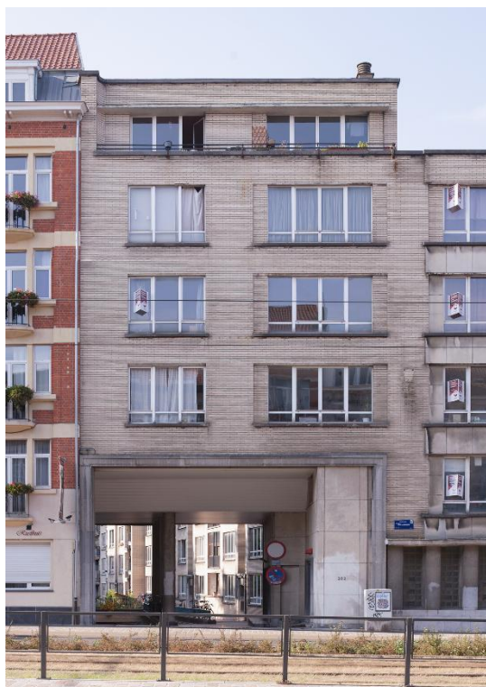
Fig. 52. Karbon', Entrée dans l'îlot , s.d., photo, Karbon'.
