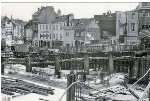
Fig. 142. Le chantier de l'immeuble avec en arrière-plan les façades des maisons, 1969, photo, Collection Jean-Pierre Huts.
