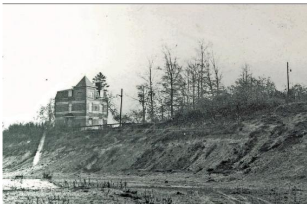
Fig. 140. Le chantier de l'avenue de la Sauvagine vue sur la villa Thomson au-dessus du talus, 1960, photo, AUW-B.
