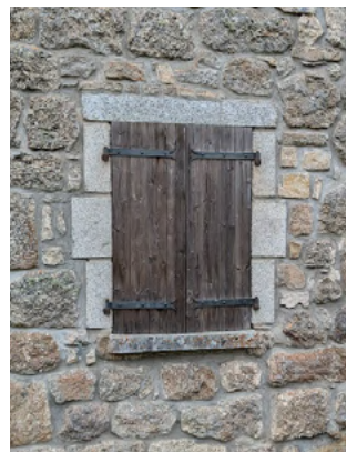
Fig 105 : Fenêtre ajoutée avec des pierre taillée avec précision en granit
