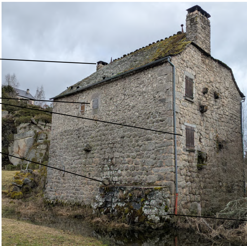
Fig 103 : Façade arrière du moulin le long de laquelle passe le bief
