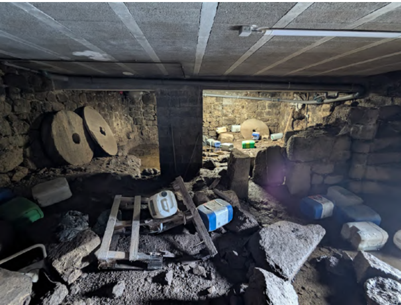
Fig 111 : Etat actuel de l'ancienne salle des machines, témoin historique de la fonction passée
