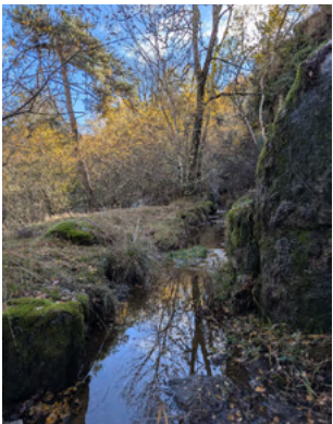
Fig 7 : Bief du moulin de Chadenet à Serverette
