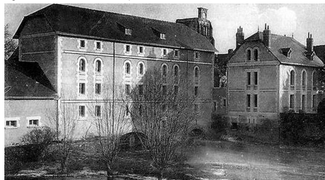
Fig 193 : Le moulin de Cormery après sa reconstruction
