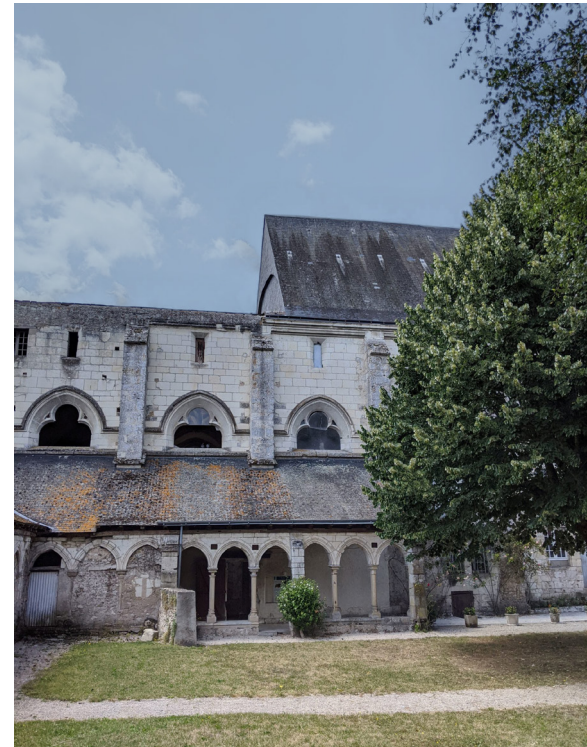
Fig 97 : Photo de la toiture du réfectoire
