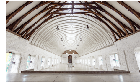
Fig 177 : charpente métallique Abbaye du Val-Saint-Lambert
