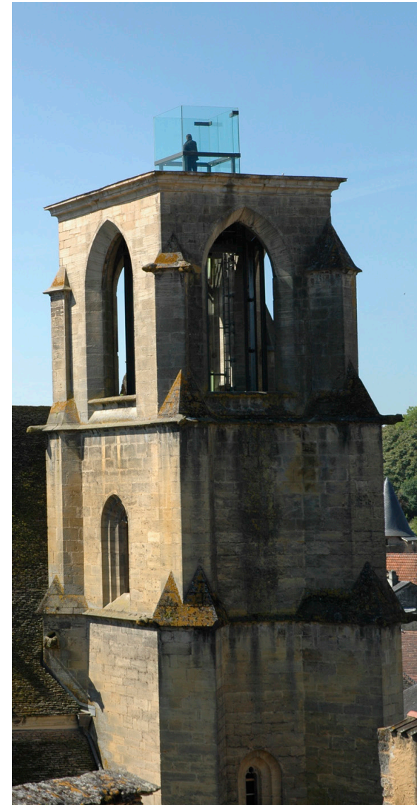
Fig 9 : Photo de l'ascenseur-belvédère en verre dans la tour
