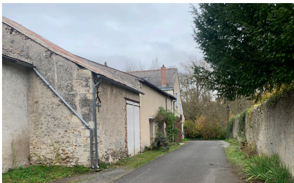
Fig 92 : Photo des garages à l'emplacement de l'ancienne aile du dortoir
