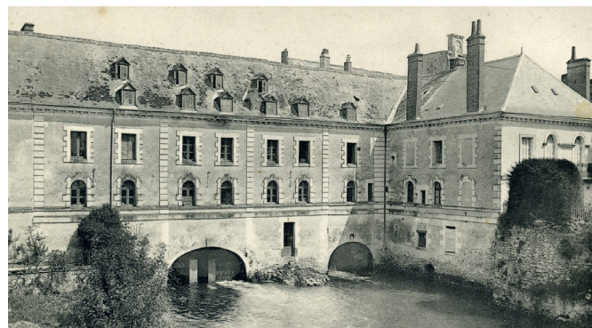
Fig 194 : Le moulin de Cormery avant l'incendie de 1908
