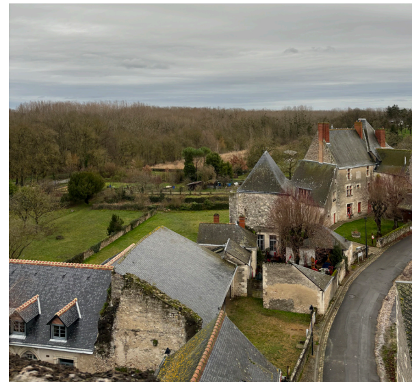
Fig 132 : Photo du site vue depuis le haut de la tour
