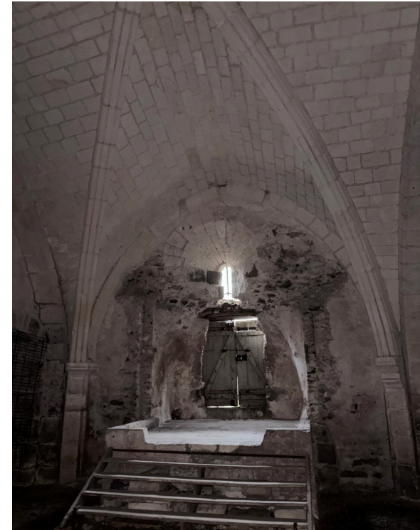
Fig 109 : Photo des celliers
