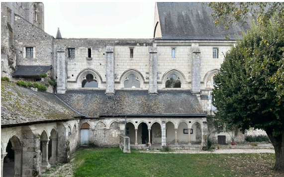
Fig 98 : Photo facade du réfectoire
