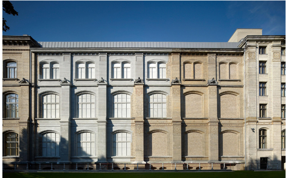
Fig 58 : Photo de la facade
