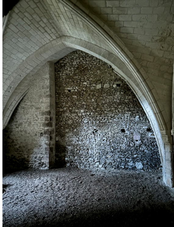
Fig 108 : Photo des celliers
