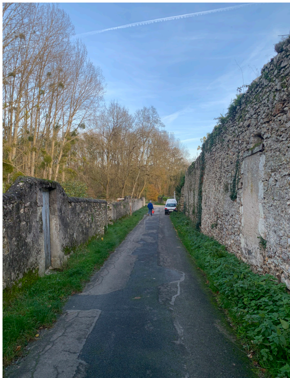
Fig 125 : Photo de site depuis l'extérieur du jardin des moines
