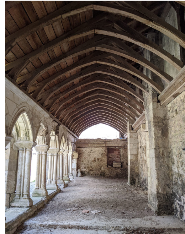
Fig 116 : Photo depuis l'intérieur du cloître
