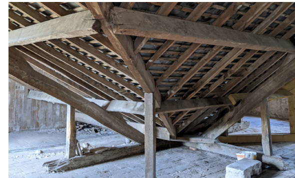
Fig 100 : Photo de la «toiture en entonnoir»
