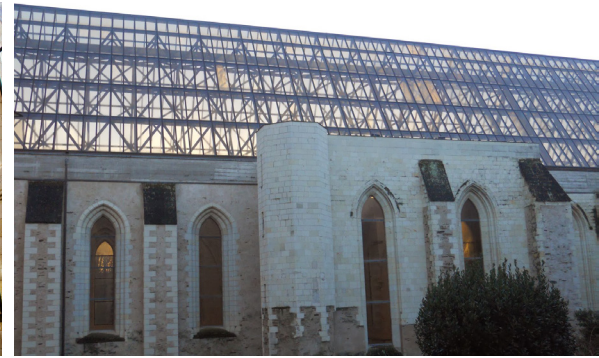
Fig 20 : Photo de la toiture abbaye de Toussaint
