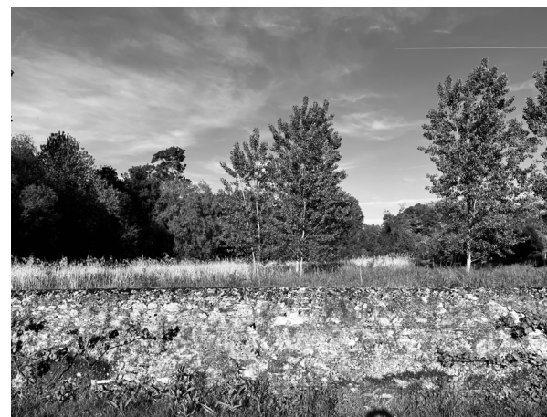
Fig 142 : Photo d'un mur
