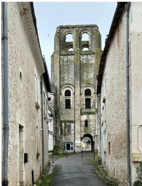
Fig 77 : Photo de la tour depuis la rue principale
