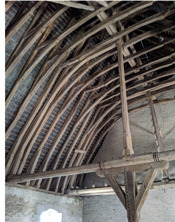
Fig 103 : Photo de la charpente à chevrons portant fermes
