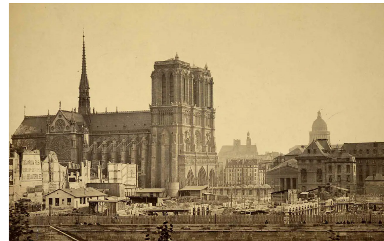
Fig 11 : Photo historique de la restauration de Notre Dame par E. Viollet-le-Duc
