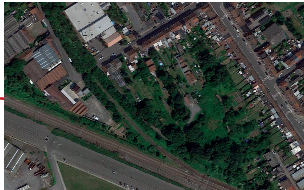
Possibilité de stocker 1 train sur cette voie abandonnée
