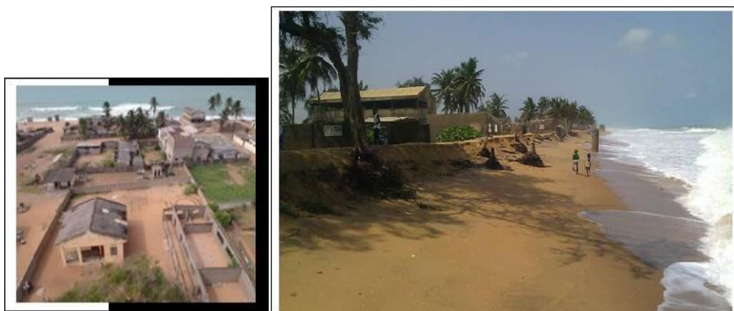
Photo n°3 : Une vue aérienne de la ville d'Agoué avec de près l'érosion océanique
