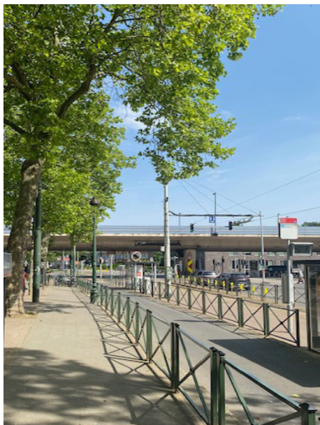
fig.32 - Le viaduc de la E411, AUTEUR, 2026.
