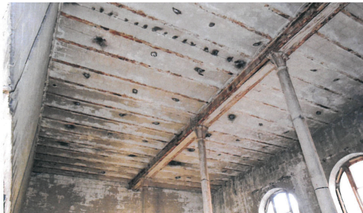
Plafond du RDC
