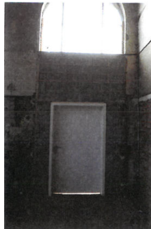
Entrée façade Sud
