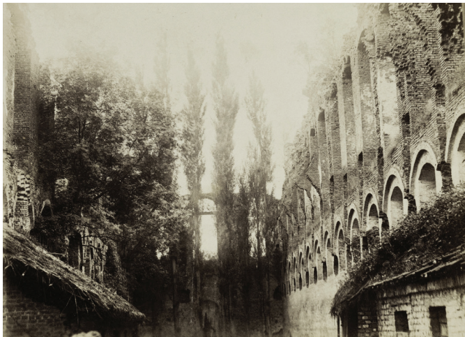
Fig. 42 - Reportage photographique du parc, Vue dans l'aile des écuries vers le sud, fin 19e (©MRM) Les toitures des habitations jadis installées dans l'aile sont visibles au bas de la photographie
