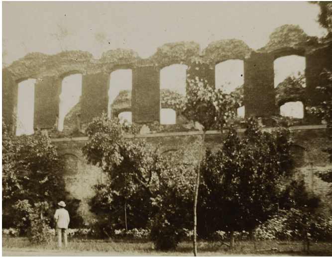
Fig. 41 - Reportage photographique du parc, Vue de la façade Ouest de l'aile des écuries, fin 19e (©MRM)
