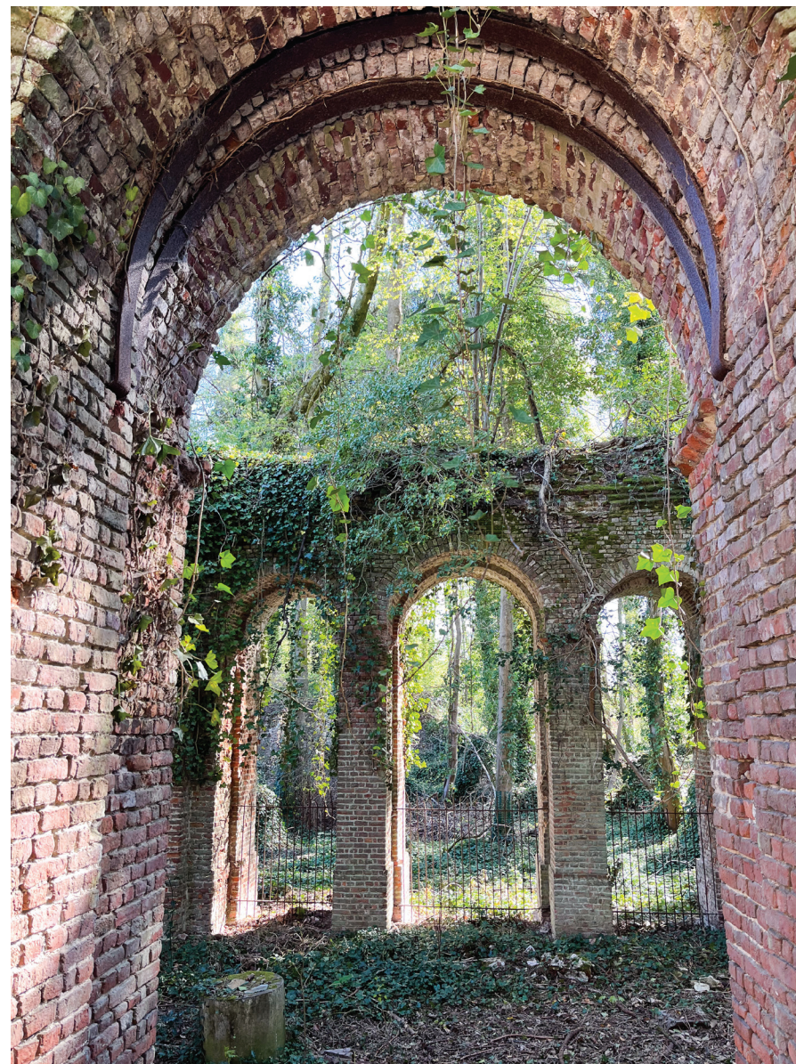
Fig.53 - Vue prise dans le vestibule. (BLONDEL, 2026)
