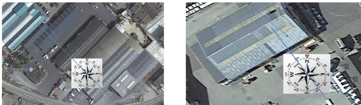
Figure 9 - Vue aérienne des toitures des sites COMARDEN de Naninne (gauche) et Bertrix (droite)
