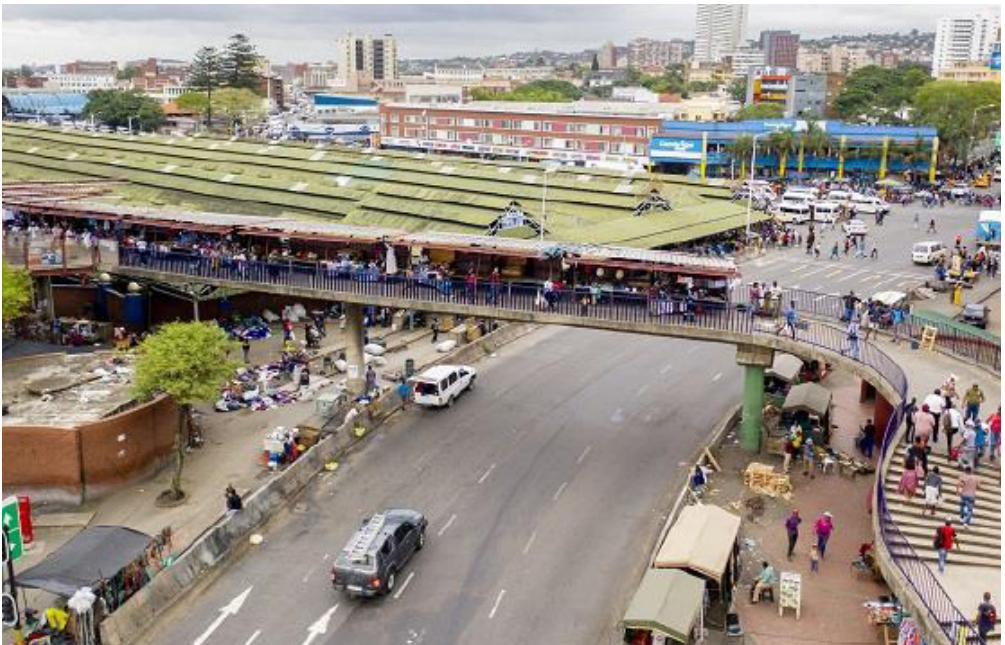
Fig. 23 : Warwick Junction de Durban en Afrique du Sud
