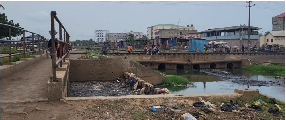
Fig. 33 : Jonction entre un collecteur et le bassin ouest de la lagune
