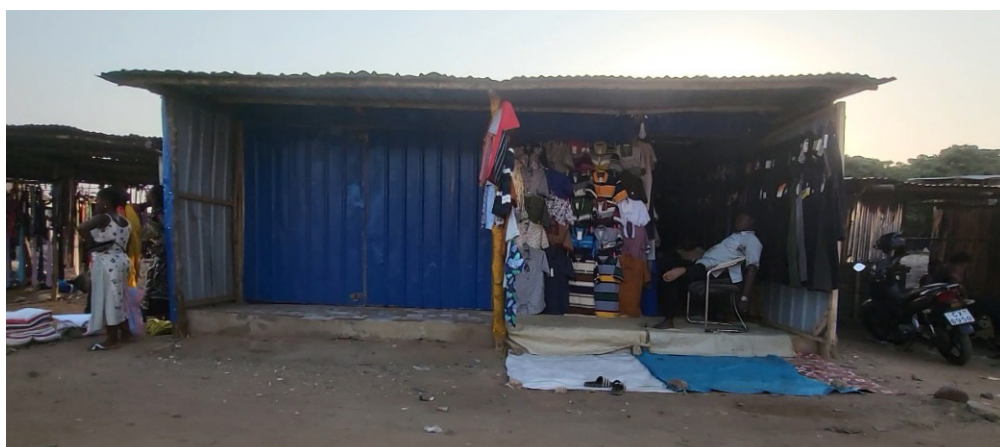
Fig. 42 : Vue d'une structure plus ancrée en tôle
