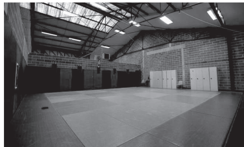
Fig. 78 : salle Deville, récemment réouverte suite à une non conformité
