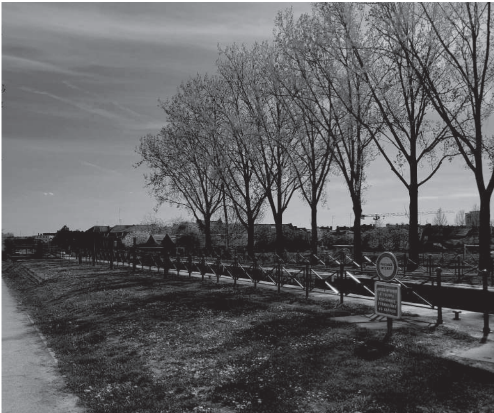
Fig. 59 : dent creuse au niveau des écluses
