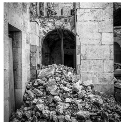
Figure 17 page ci-contre Palier intermédiaire, pierres du site en murs, brique en pavement.
