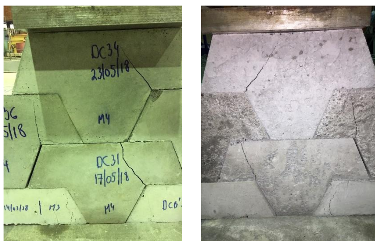
Figures 277 - Fissures observées (vue de face et vue de derrière)
