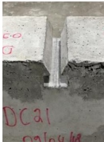
Figure 232 - Ponçage des angles de la rainure
