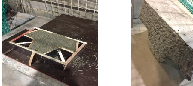
Figures 168 - Remontée des billes d'Argex lors du coulage
