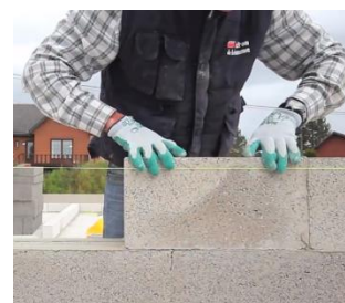
Figures 61 - Mise en place des blocs rapide et sans pression verticale
