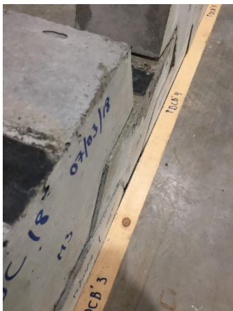
Figure 132 - Imprécision de pose latérale
