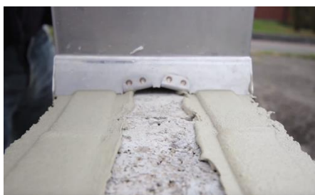
Figure 60 - Dépôt de mortier-colle par glissement de bac-distributeur
