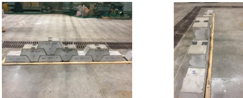
Figures 247 - Mur de DEPT construit par drone avec le GGS-EM
