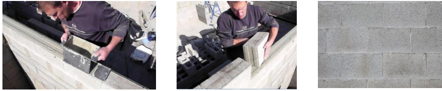
Figures 62 - Montage de blocs par mortier-colle et joints fins obtenus
