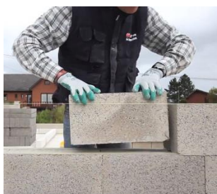
Figures 61 - Mise en place des blocs rapide et sans pression verticale
