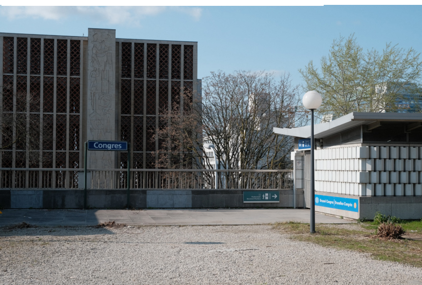
Pavillons d'accès à la gare du Congrès depuis l'esplanade (2026)
