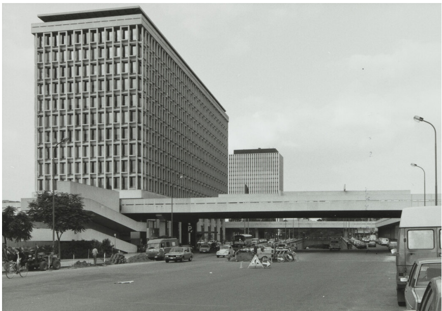
Passerelles joignant la Cité à l'ancien siège de Crédit communal (1985)
