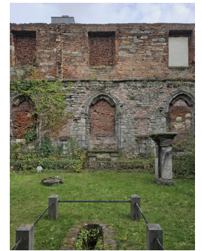
Fig. 89 | Façade est de la salle capitulaire et du dortoir.
