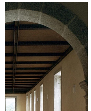
Fig. 30 | Les poutres en acier soutenant le plancher.
