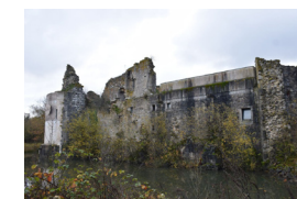
Fig. 11 | Restauration du château de Fagnolle.
