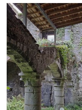
Fig. 84 | Les voûtes au rez-de-chaussée.
