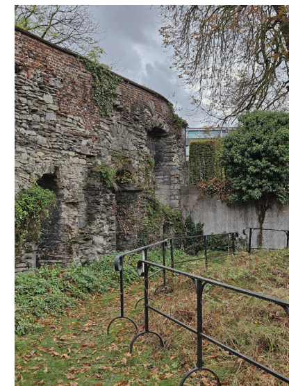
Fig. 98 | Le mur occidental du cloître.
