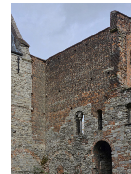
Fig. 83 | Façade ouest du scriptorium.
