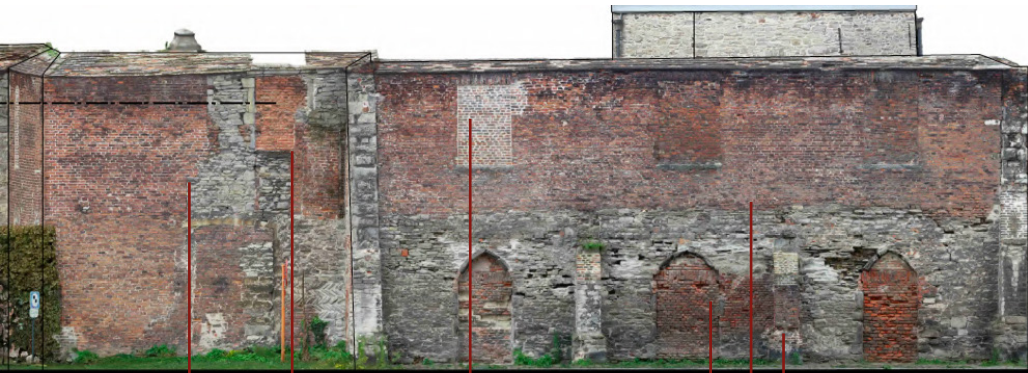
Baies obturées Baie obturée, mortier blanc Contreforts extérieurs Reconstruction en brique du 18 e s. Baie gothique obturée Couture pour la construction du dortoir
