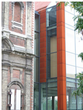
Fig. 26 | La jonction entre l'ancien et le nouveau.
