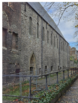
Fig. 80 | Façade nord du bâtiment.
