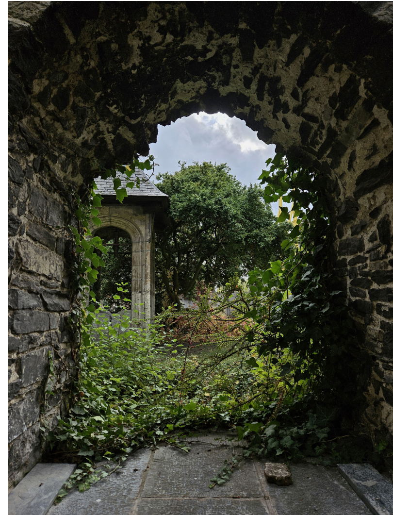
Fig 139 | Vue vers le puits à travers le passage.
