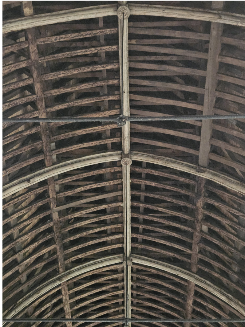
Fig 136 | La charpente en bois lambrissée du réfectoire.
