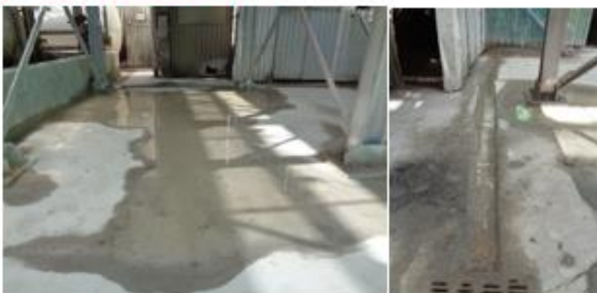
Mauvais écoulement des eaux sous la citerne et derrière les bacs de décantation
