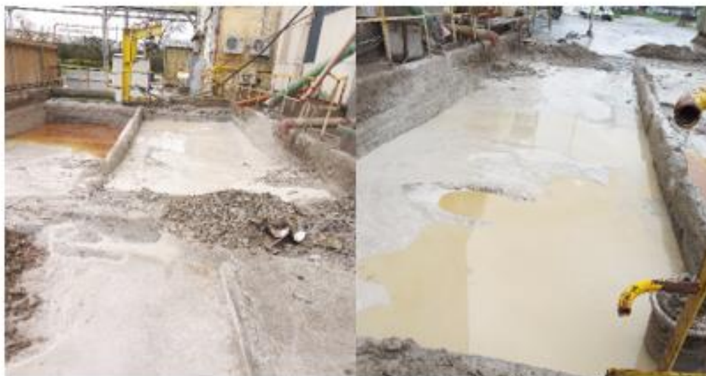
d. Boues trop épaisses dans les bacs de décantation
