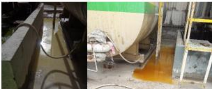
Mauvais écoulement des eaux sous la citerne et derrière les bacs de décantation
