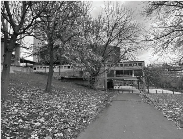
Fig. 42 - Balade architecturale, matérialisé par une asphalte rouge
