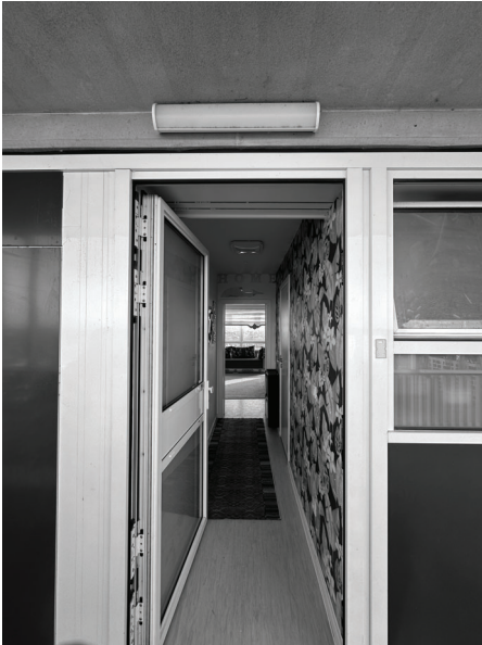
Fig. 19 - Transition brutale entre la coursière et le logement. Articulation réduite à l'épaisseur du châssis
