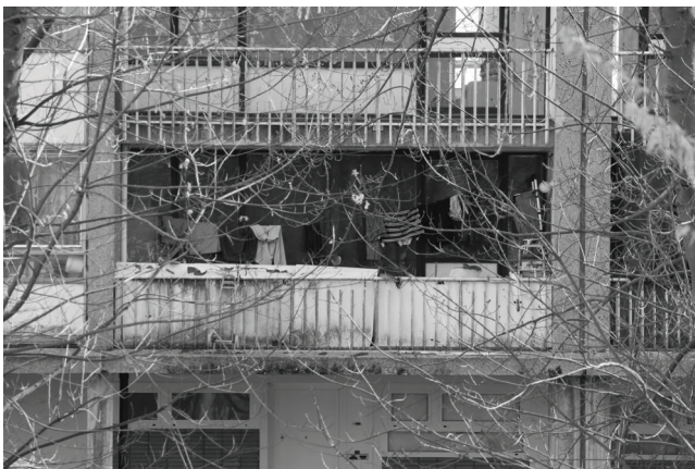
Fig. 16 -Appropriation des terrasses du bloc 6 et 7
