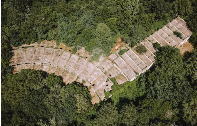
Fig. 30 : Exemple de rotonde désaffectée - Rotonde de Bénestroff (57 - France)
