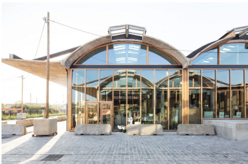
Fig. 94 : Vue sur la halle B - Saint-Sauveur
