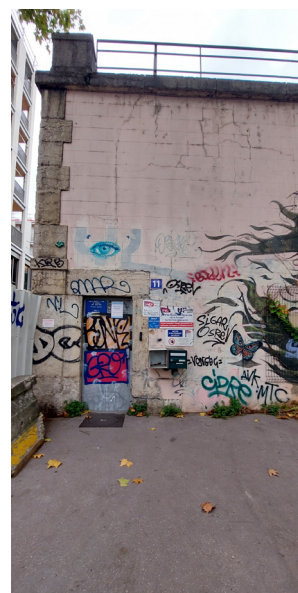
Fig. 106 : Porte d'accès menant à la rotonde
