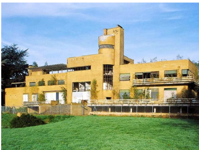
Fig. 10 : Etat dégradé de la Villa Cavrois avant le début des travaux de restauration en 2003
