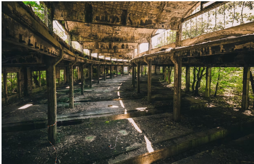
Fig. 31 : Exemple de rotonde désaffectée - Rotonde de Bénestroff (57 - France)
