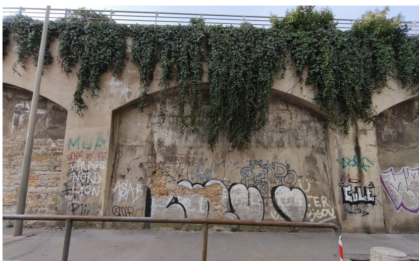
Fig. 109 : Abords - Mur de soutènement avec des arches
