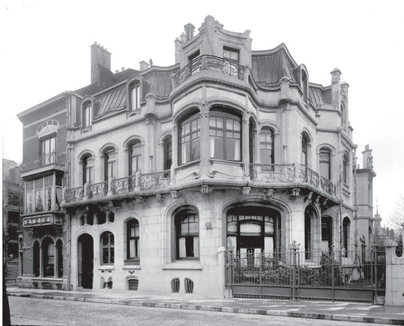
Fig. 25 : Vue de l'Hôtel Aubecq avenue Louise avant sa démolition (Bruxelles, Belgique)
