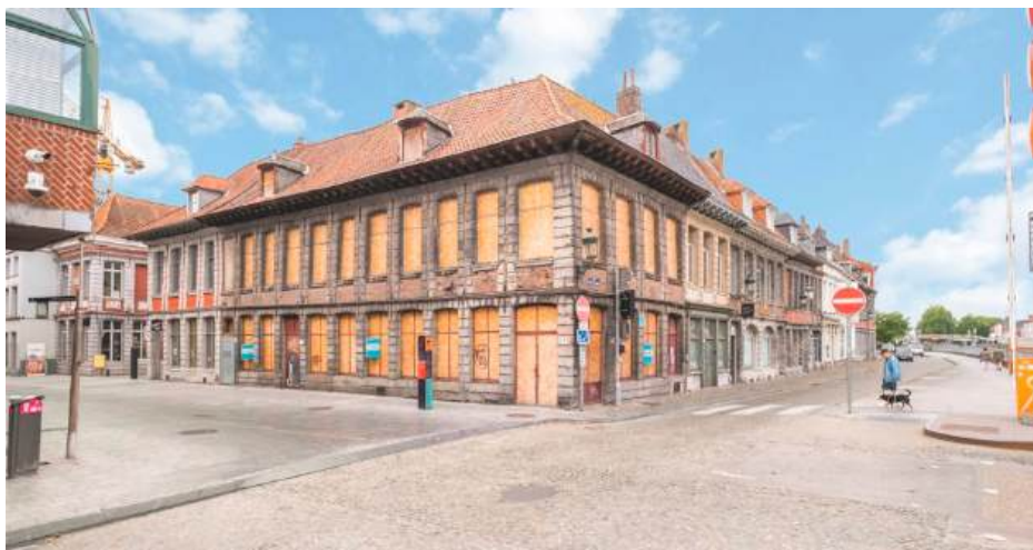
Le bâtiment existant © Ait-Ali Amélia
