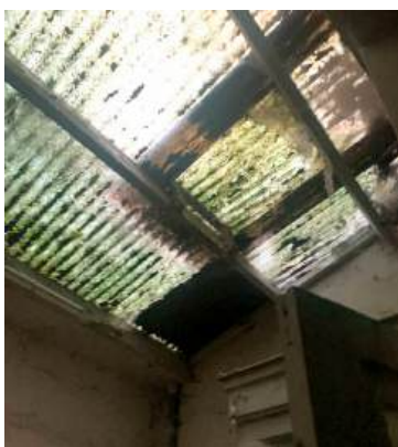
La toiture de l'espace 2 © Aït-Ali Amélia
