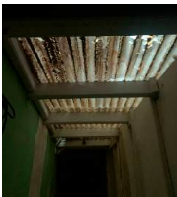
La toiture de l'espace 1 © Aït-Ali Amélia
