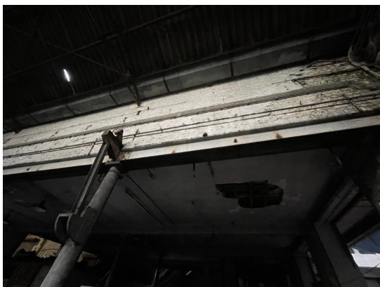
Vue sur le rdc de l'ancienne Mégisserie (photo personnelle)
