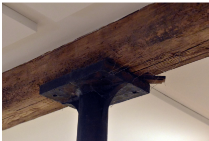
Rue de Gheude 56 - colonne en fonte et poutre en bois, 2019 (source : urban)
