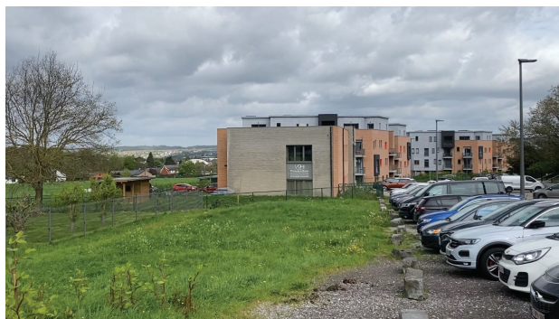
Fig. 22 - Photo des nouveaux lotissements et d'un de ses parkings (Auteure, 2024)
