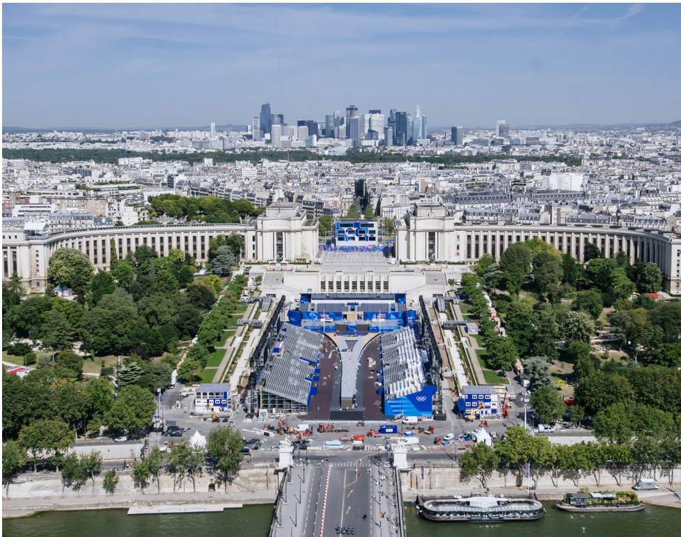
Figure 60 : Photo des l'installations temporaires du podium de présentation au trocadéro de GL event
