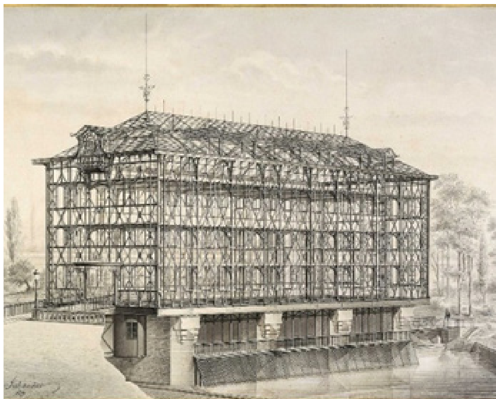
Figure 6 : Ossature chocolaterie Menier à Noisiel
