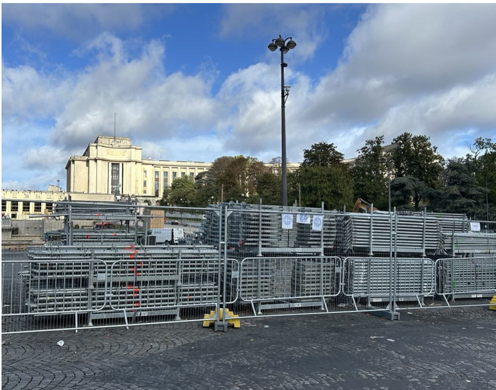
Figure 61 : photo du démontage du podium de présentation au trocadéro de l'auteur
