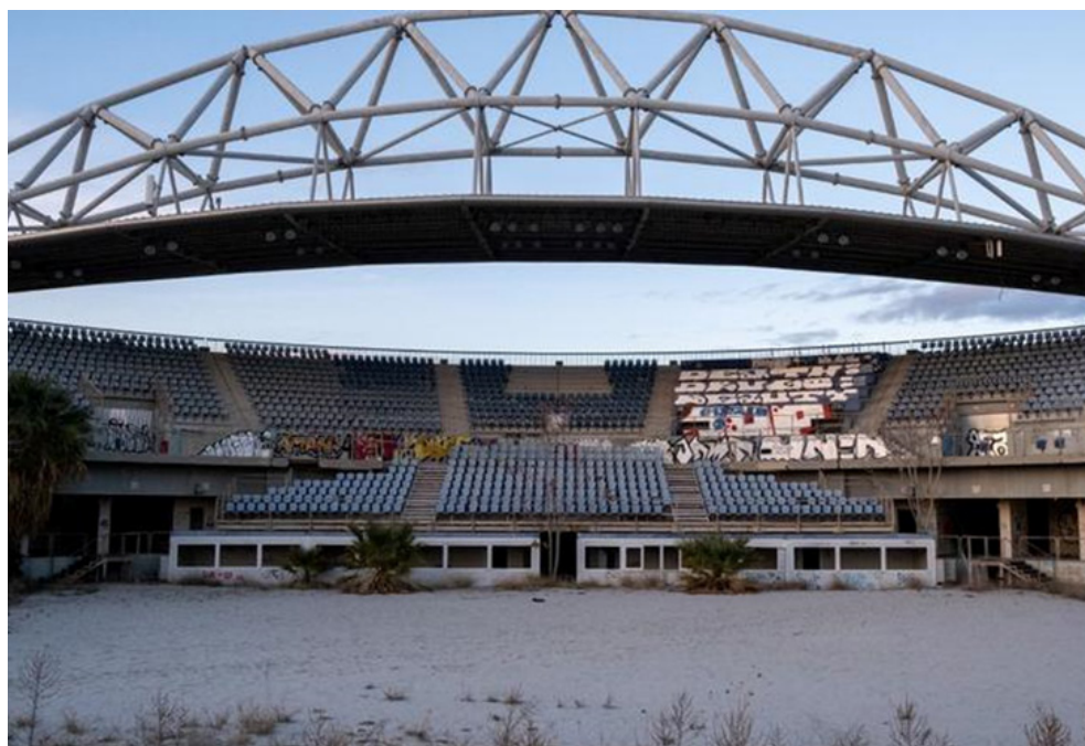
Figure 13 : En janvier 2023, le stade olympique de Faliro. Il accueillait des épreuves de beach-volley lors des Jeux olympiques de 2004 et est aujourd'hui à l'abandon. Photo MARTIN BERTRAND
