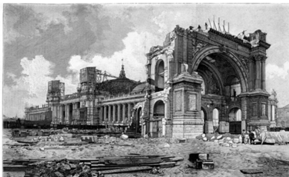
Figure 10: destruction du palais de l'Industrie et construction du Grand Palais
