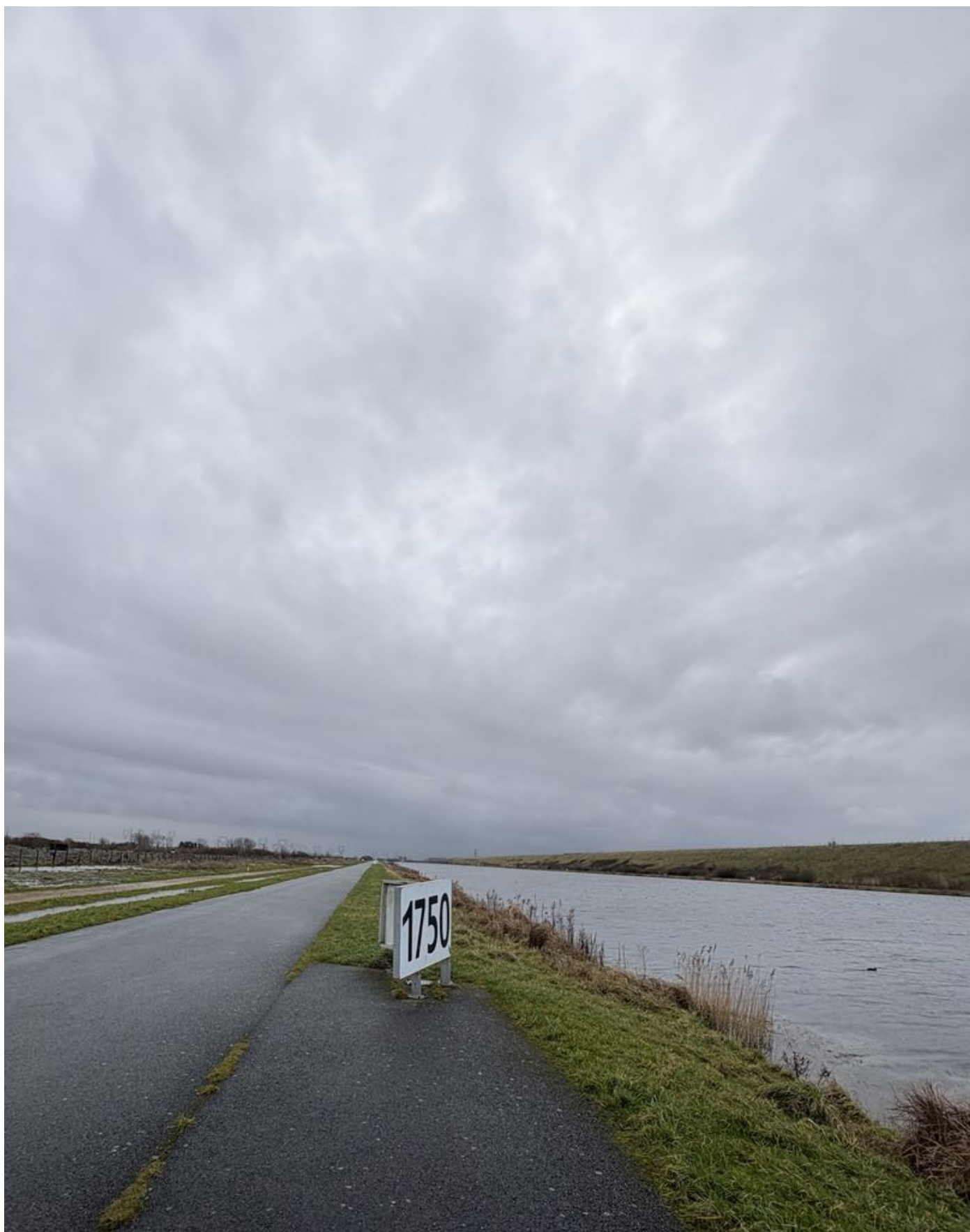
Figure 66 : photo depuis la promenade piétonne de l'auteur
