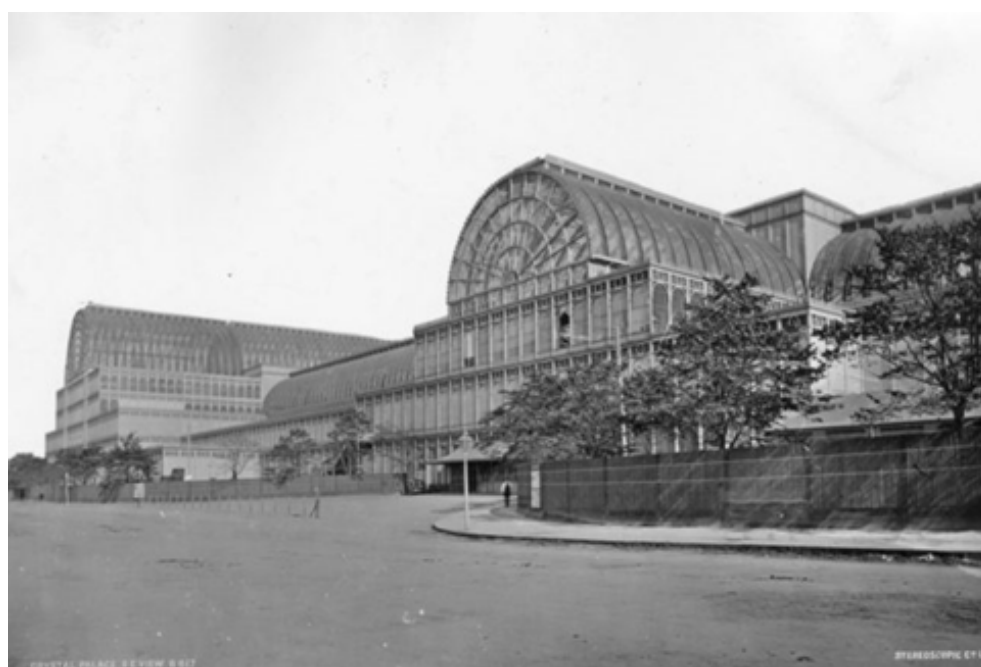
Figure 18 : Crystal palace après son démantelement à Sydenham
