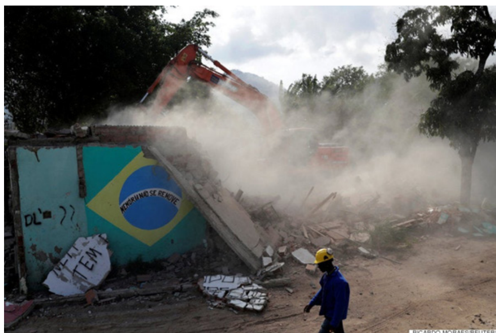
Figure 11 : Démolition lotissement de vila Autodromo 600 familles déplacées
