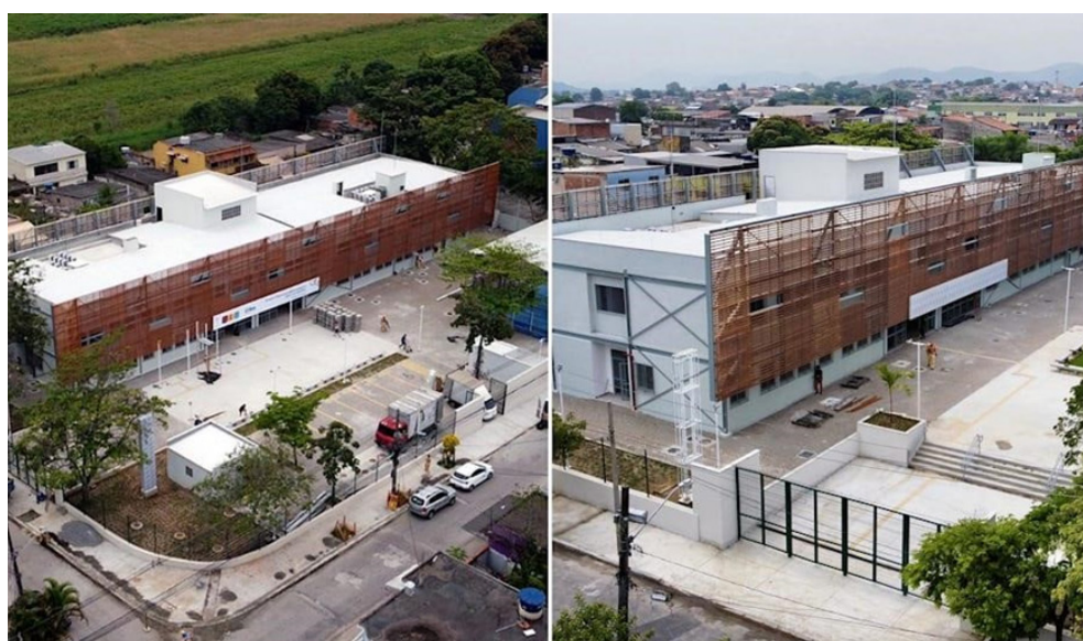
Figure 25: photo des écoles une fois le démantèlement effectué
