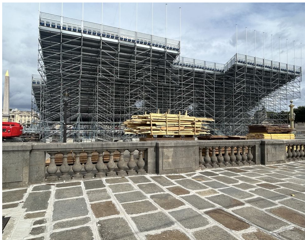
Figure 63 : photo de la place de la concorde pendant le démontage de l'auteur
