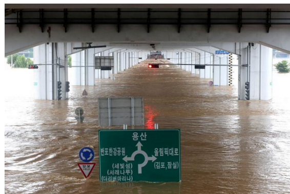
FIGURE 2.1 – Inondation pluviale de Séoul en août 2022 [LE MONDE 2022].
