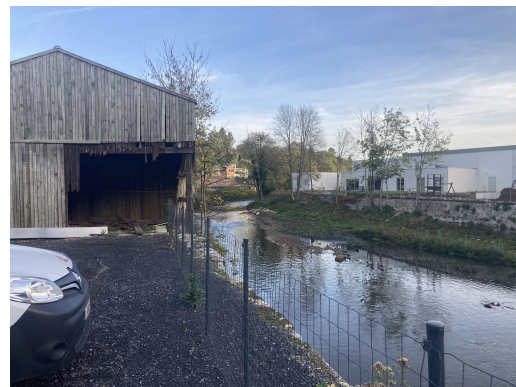
FIGURE 3.7 – Dégâts sur une construction en bois. [RYCKMANS 2022]
