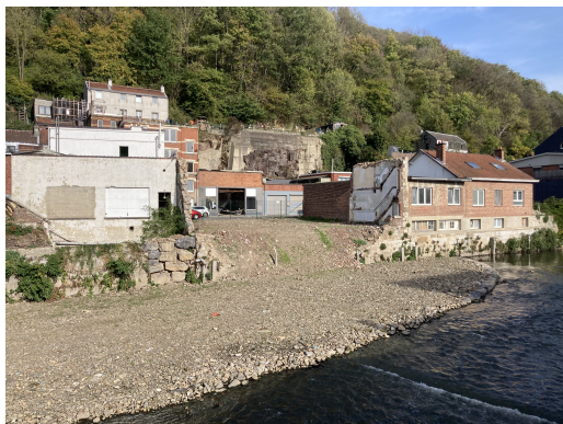
FIGURE 3.6 – Ruines d’un bâtiment. [RYCKMANS 2022]
