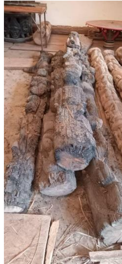
Figure 12 : récupération des piliers après l'incendie de 2005
