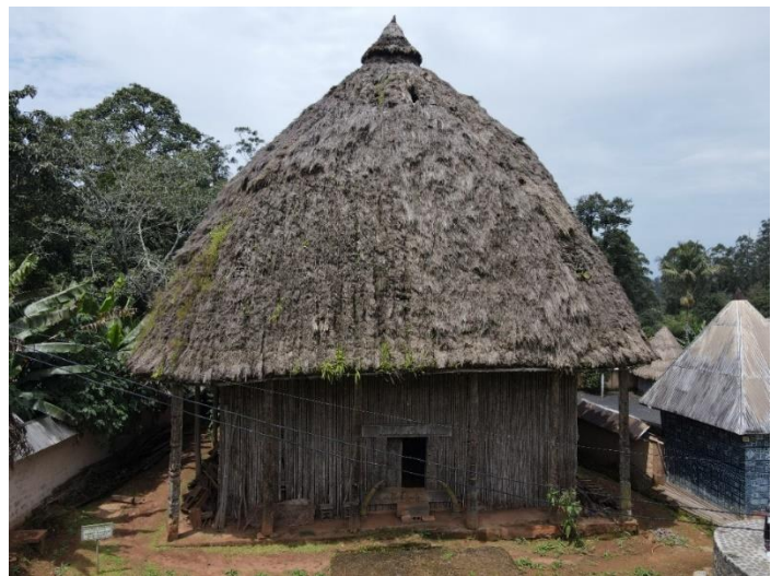
Figure 31 : vue générale sur la grande case du peuple
