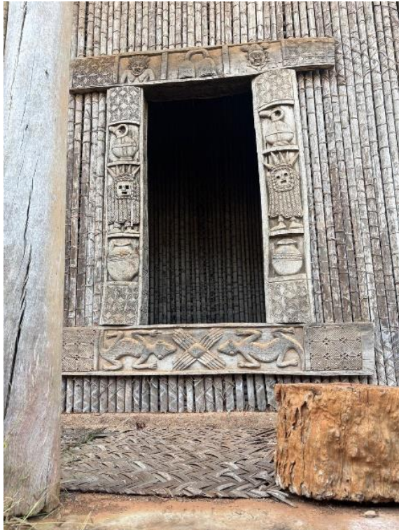
Figure 49 : porte de la façade Ouest
