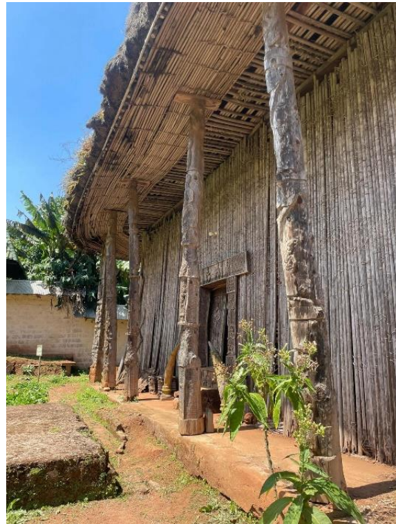
Figure 45 : les différents piliers de la façade Est
