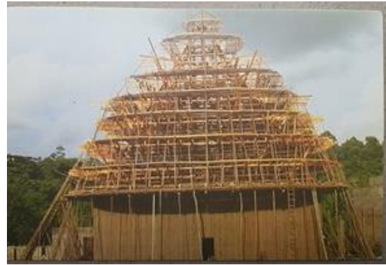
Figure 58 : phase de construction de la grande case du peuple bandjoun en 2005.
