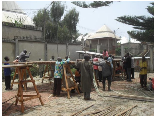
Figure 62 : chefferie Bandjoun, préfabrication des sacpa en 2005
