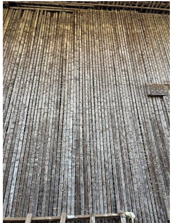
Figure 77 : salissures sur des piliers, parois en raphia
