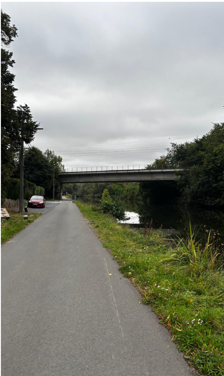
Fig 25 : RAVeL passant sous un pont ferroviaire Auteur, 2026
