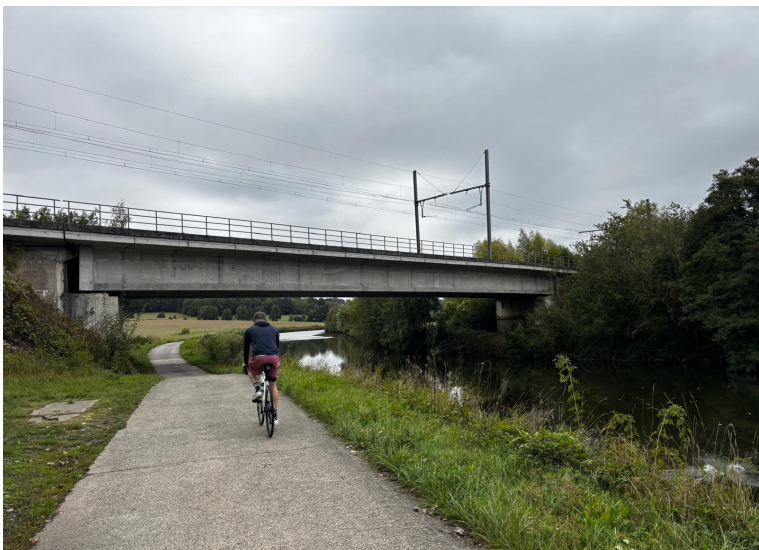
Fig 06 : Pont ferroviaire franchissant la Sambre Auteur, 2025
