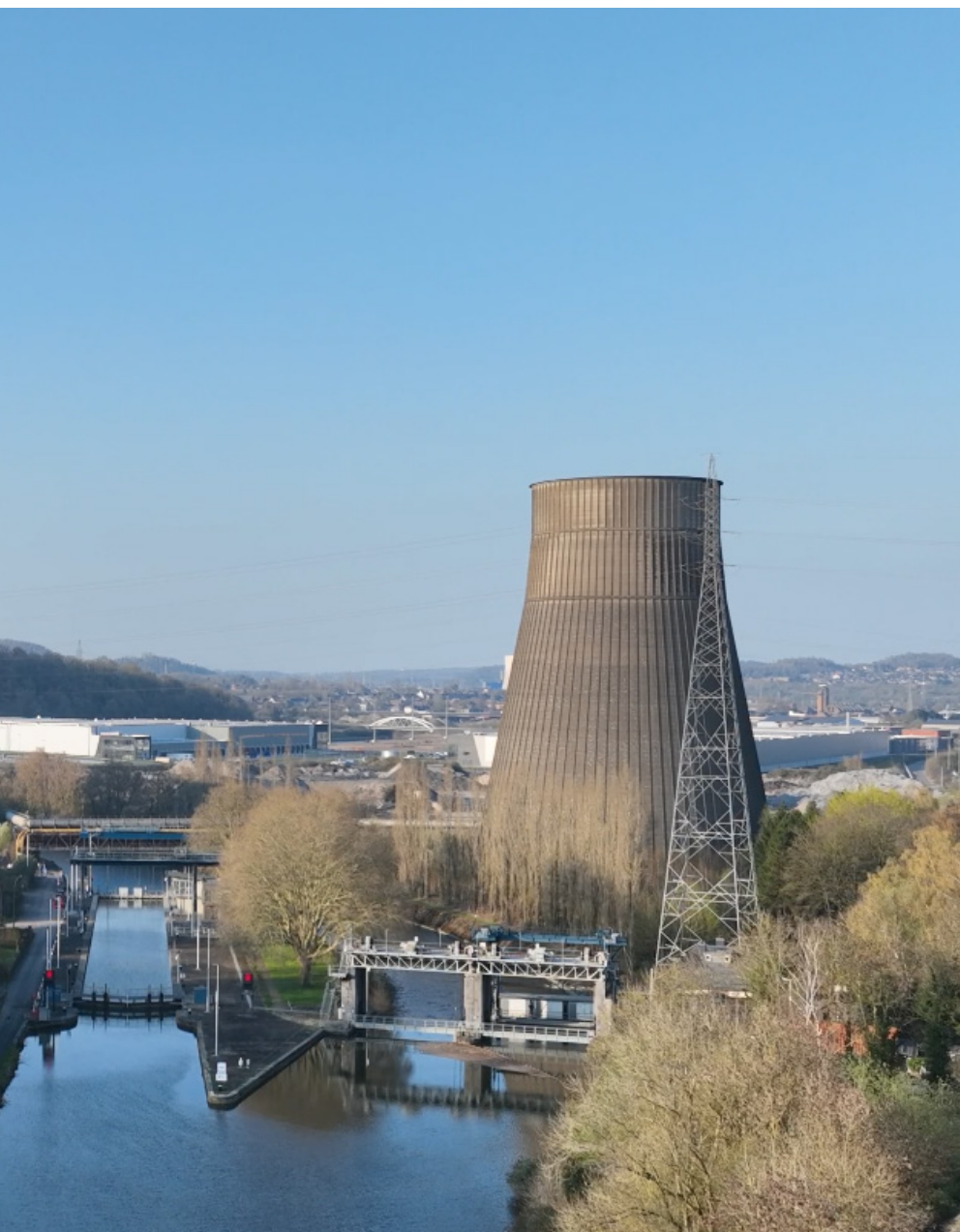
Fig 47 : Vue aérienne de la tour de refroidissement Stephane Gallardo, 2026
