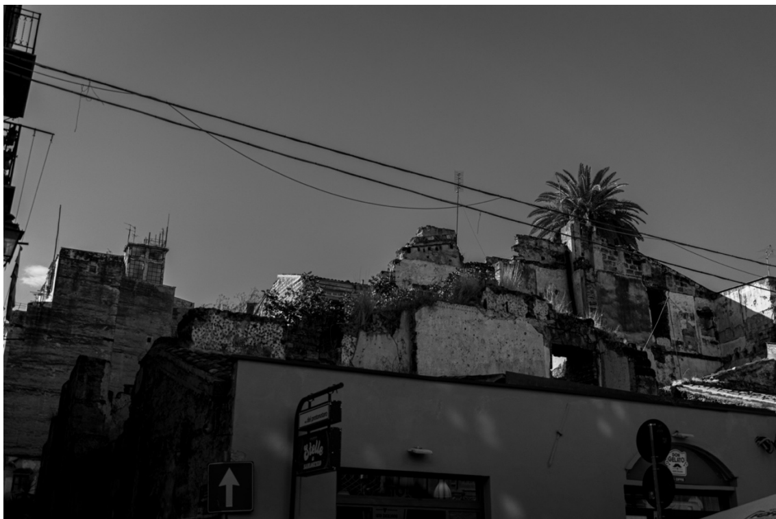
Figure 1: Un bâtiment dans une rue du centre détruit par les bombardements américains
