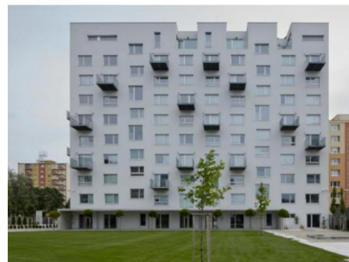
Fig 83. Immeuble après les travaux de rénovation
