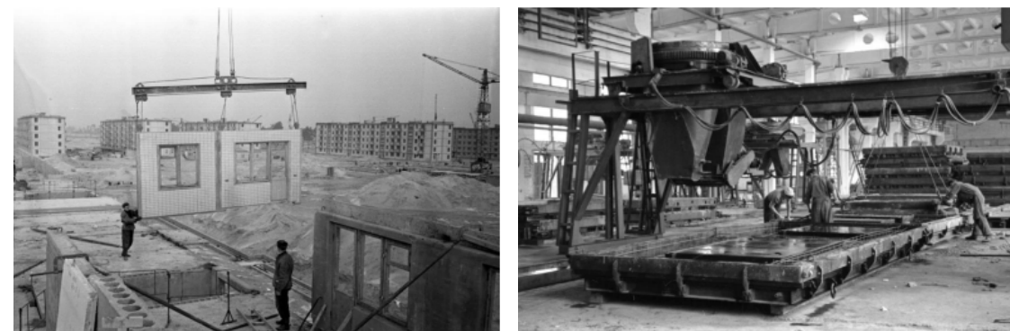
Fig 27. L'usinage et assemblage des panneaux, 1960. ©S. Pshenynhogo
