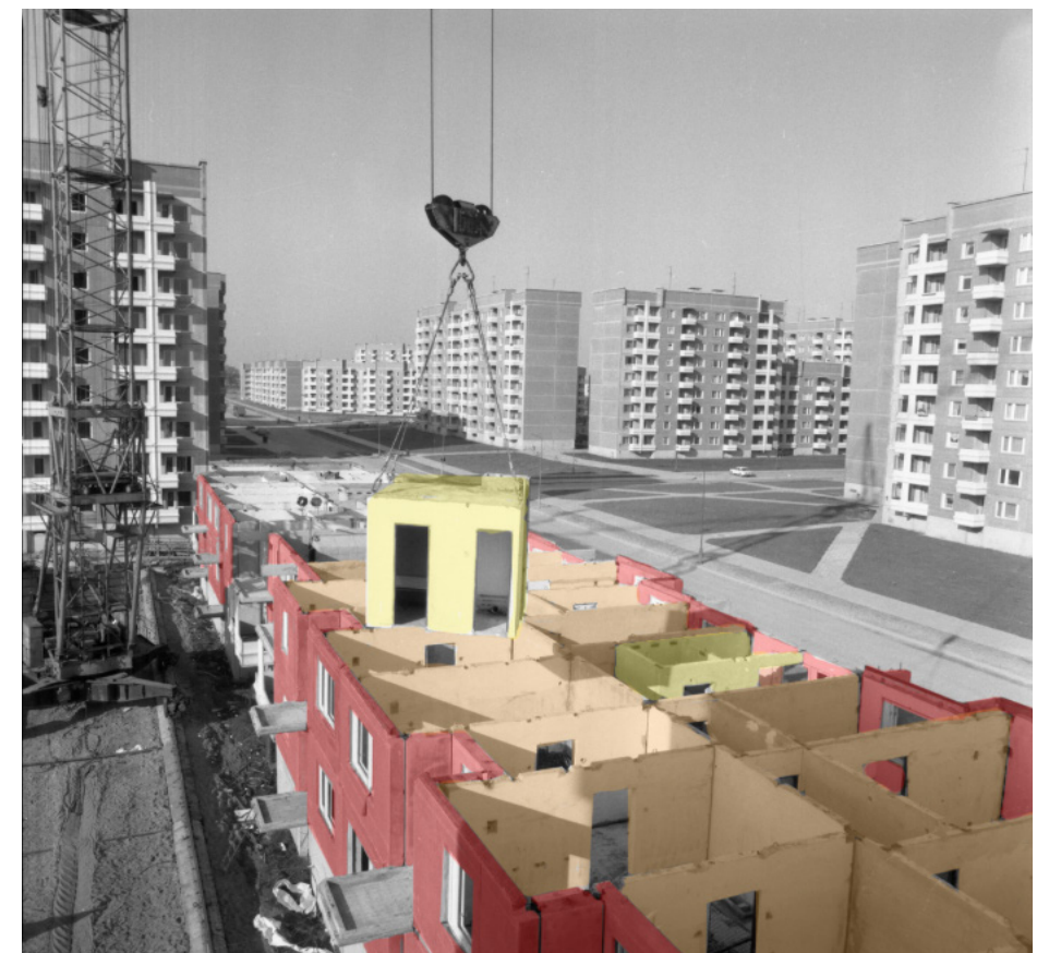
Fig 28. Assemblage des différents éléments en panneaux préfabriqués grâce aux grues sur des rails. Source : photo initiale faite par Bernardas Aleknavicius 1987-1988.
