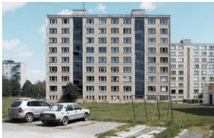
Fig 81. Immeuble avant les travaux de rénovation
