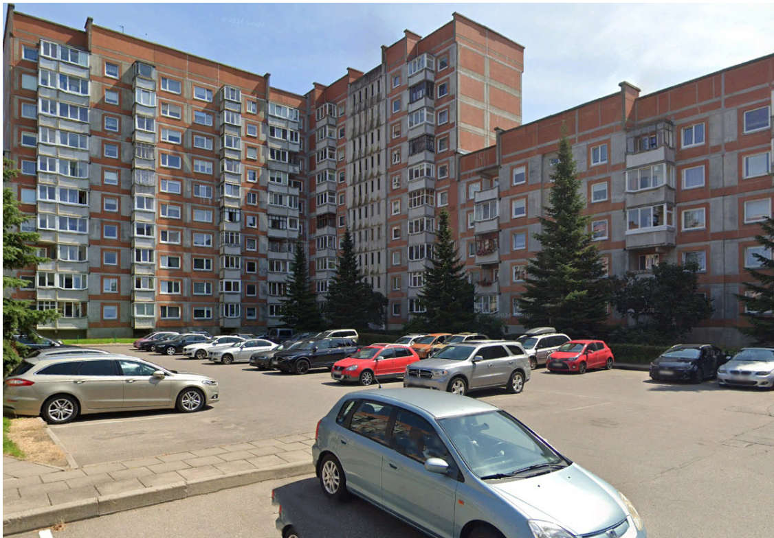
Parking au pied des immeubles
