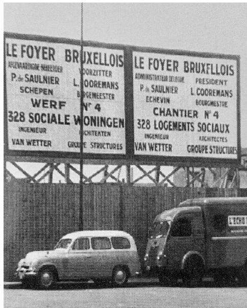
Fig. 7 - Début du chantier Rempart des Moines, 1964
